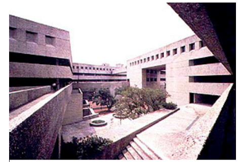
Arq. Abraham Zabludovsky/ Arq. Teodoro González de León. Universidad Pedagógica Nacional, Ciudad de México, 1979. Vista de un patio interior.
