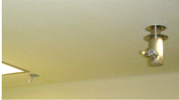
Figura 1.6.3 Sistema de colección de polvos a nivel plafón para procesos de fabricación
