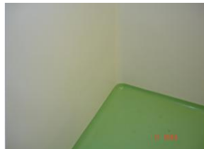
Figura 1.8.1 Piso con acabado y curva sanitaria
