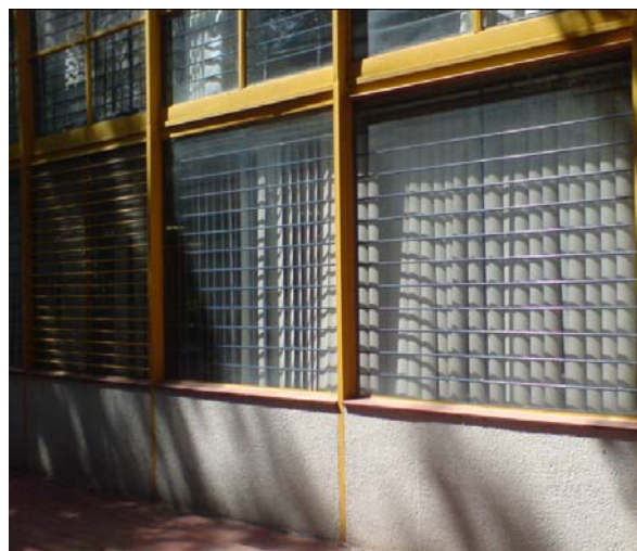
Fig. 2-14 Vista exterior de los muros
