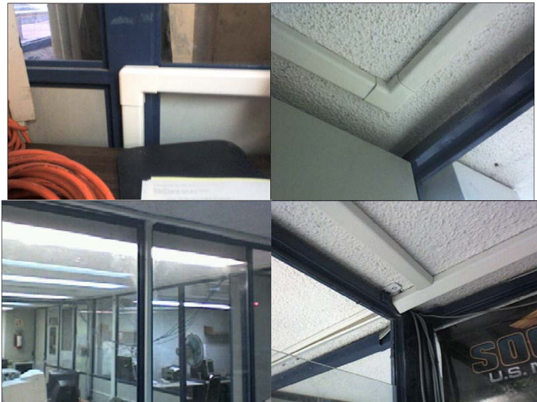
Fig. 3-3 Instalación de canaleta
