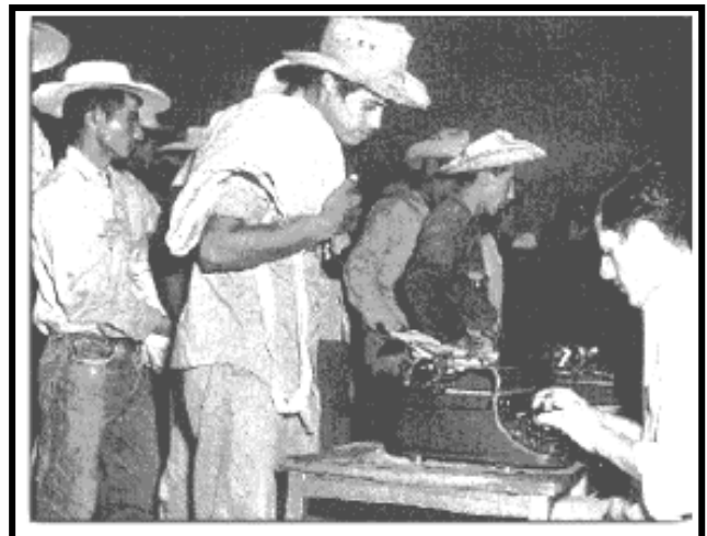
Contratación de braceros
