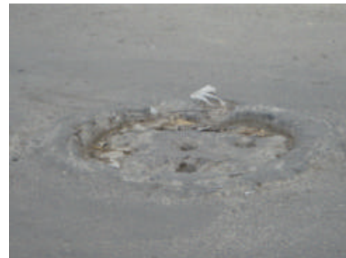
Drenaje y alcantarillado
