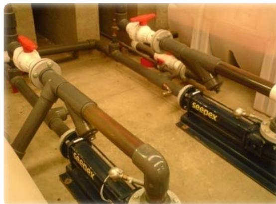
Fig. 6.12 Bombas de cavidades progresivas
