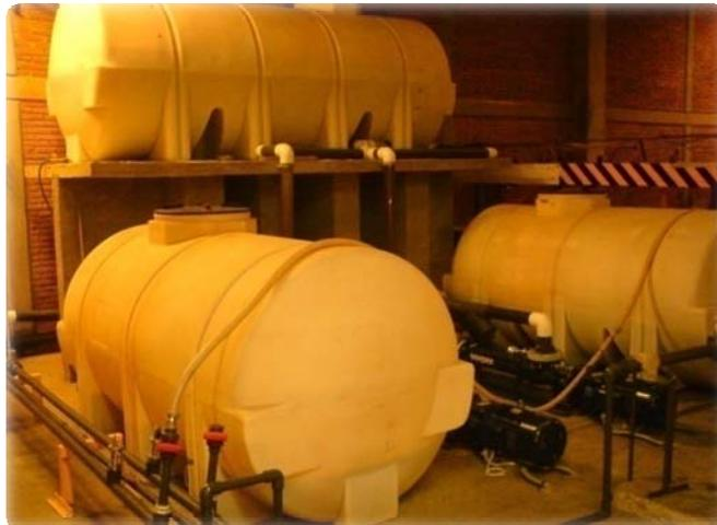
Fig. 6.17 Separador (parte superior) y tanques de almacenamiento de agua y aceite.
