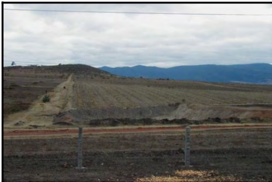
Vista de una excavación en un campo de cultivo.
