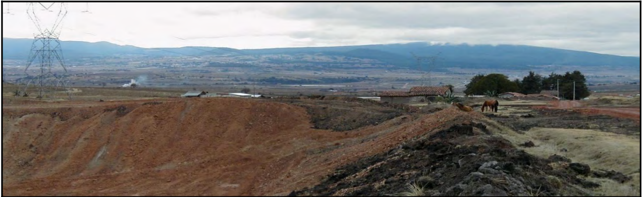
Excavación para establecer un embalse cerca de Villa Cuauhtémoc.
