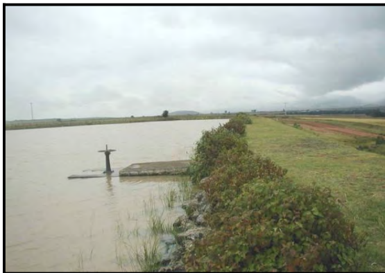
Área de la compuerta en octubre, el agua llega a cubrir la manija de apertura de la misma.
