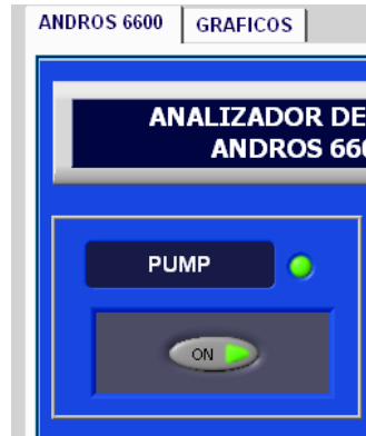
Figura VI.2 Accionamiento de la microbomba en el Panel de Control Maestro
