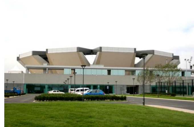
Imagen 14 El Olympic green tennis center en Beijing.
