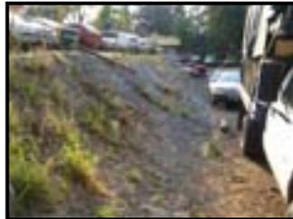
Taludes dentro del estacionamiento para absorber cambios de nivel.
