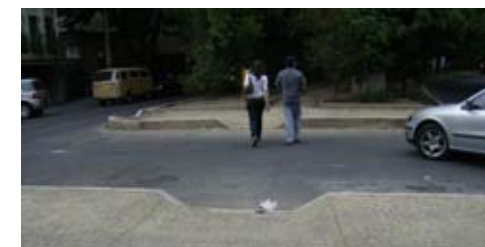
Fig. 3.22 Falta de continuidad y seguridad en los pasos peatonales
