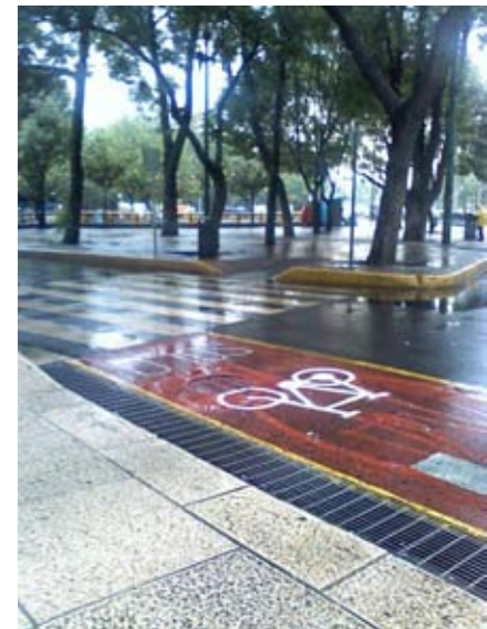
Fig. 4.23 Ciclovia con superficie balizada ciclovia de la cd. de México
