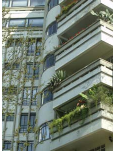
Fig. 3.34 Edificio Basurto, Ámsterdam
