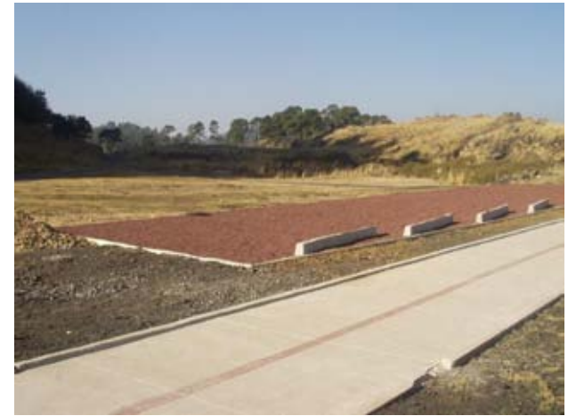
Fig. 4.20 Ciclovía con superficie de concreto, ciclovía rural de la cd. de México
