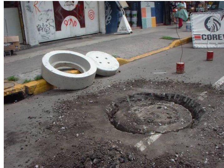
Obras de Urbanización
