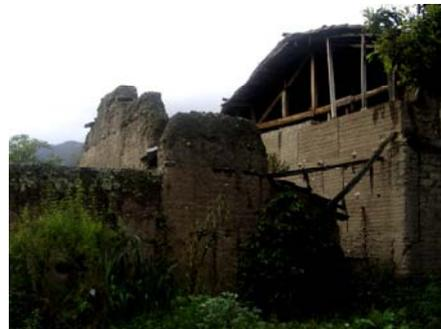
Por acción de la lluvia la casa ha perdido parte de la cubierta, en la fachada poniente, que ha conllevado al deterioro de los muros de esta sección
