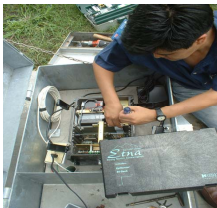
Figura 3.10 Instalación, orientación y calibración de acelerógrafos Etna Kinematics.
