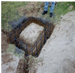
Figura 3.4 Excavación para base, excavación para suministro de servicios y parrilla perimetral.
