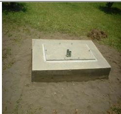
Figura 3.5 Armado, cimbrado, vibrado y colado de base de concreto, salidas para suministro de servicios.
