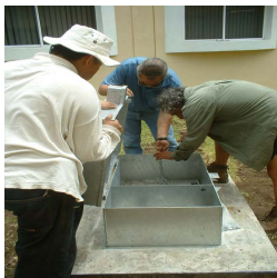
Figura 3.6 Instalación de caseta metálica prefabricada, nivelado atomillado y sellado.
