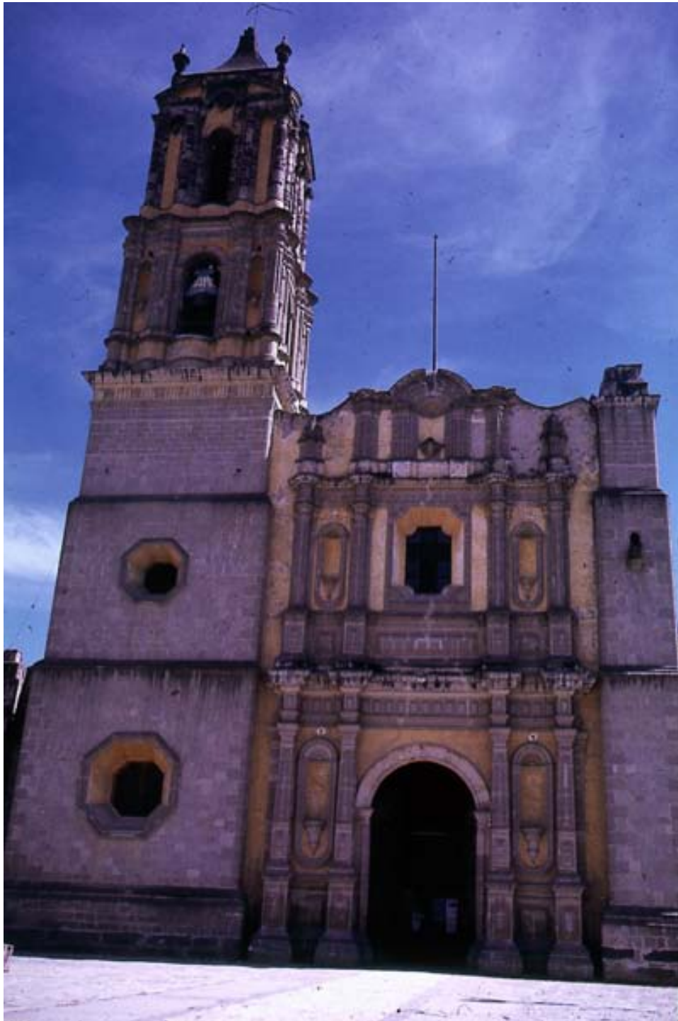
Fachada del ex convento de Cuautitlán, Estado de México.
