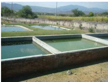
Figura 35. Estanques construidos de tabique.
