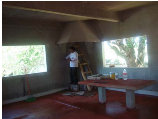
Figura 48. Construcción del rastro.
