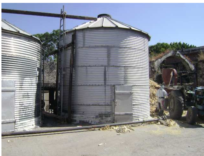
Figura 4. Tolvas para el almacenamiento de grano.
