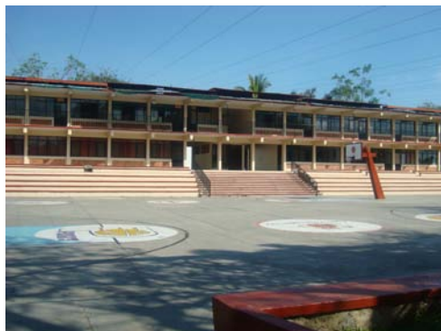
Figura 3. Aspecto parcial de las instalaciones.
