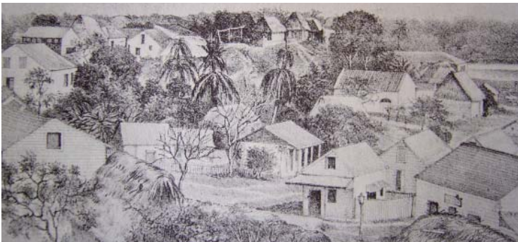
Fig. 6. Ejemplo de construcción en madera en Veracruz
