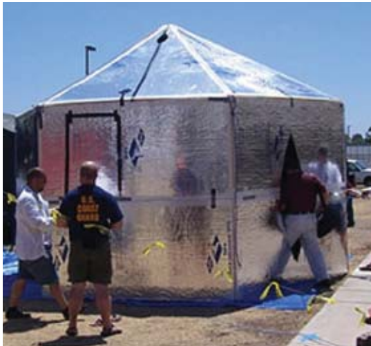
Fig.23. La hexagonal casa de tableros de carton recubierto, diseñada por Lindsey Darby y Vinay Gupta, es fácil de transportar y montar, hecha con materiales resistentes de bajo costo. Con diferentes tamaños según su necesidad.
