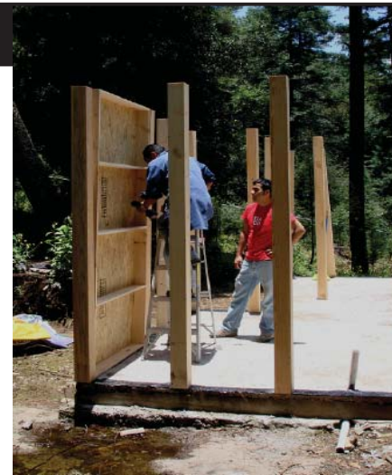
MONTAJE Segunda etapa; Fijación de Paneles Verticales a conectores verticales:
