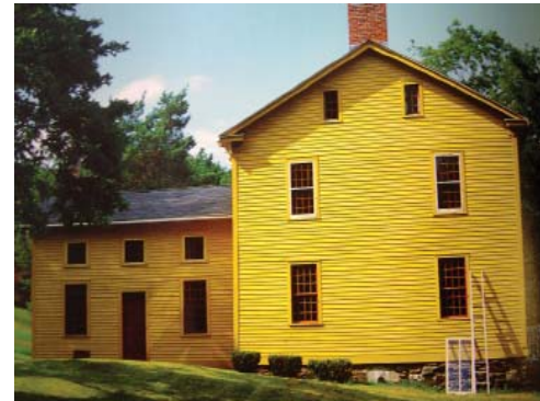
Fig. 1. Ejemplo de construcción en madera en Estados Unidos
