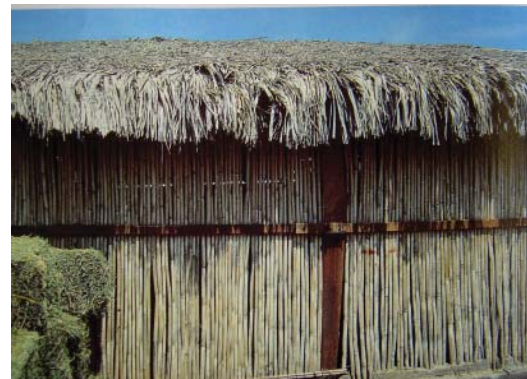
Fig. 8. Ejemplo de construcción en madera en Baja California Sur
