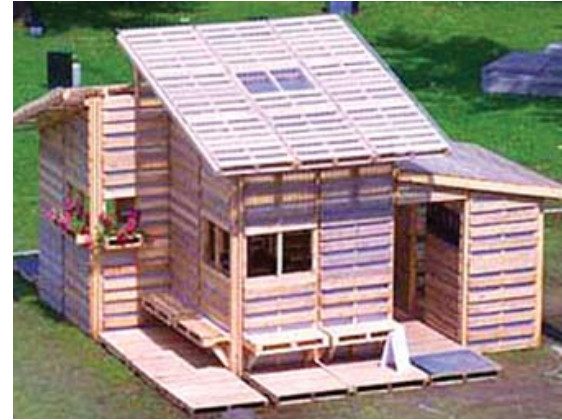
Fig.19 y 20. Pallet House, concebido por I-Beam Design, vivienda emergente de bajo costo en madera utilizando módulos prefabricados y accesibles materiales, no requiere herramientas complicadas, es factible de adecuaciones futuras. Es de sencilla transportación y puede ser reusado varias veces. Sistema propuesto para el Tsunami en Sri Lanka en 2004.
