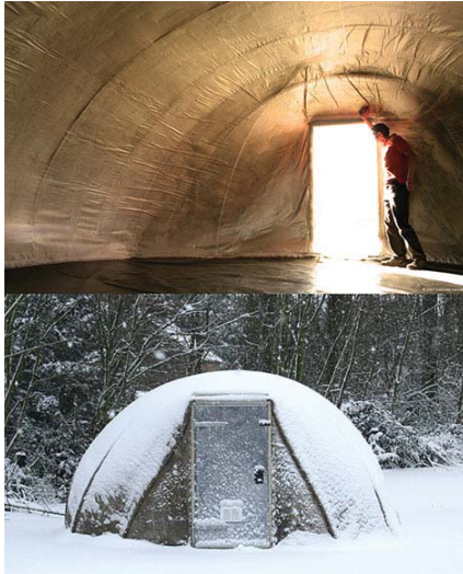
Fig.22. Un grupo de ingenieros británicos, Peter Brewin y William Crawford, diseñaron un prototipo de vivienda de corto plazo, con alta tecnología para su rápida instalación, una vivienda en concreto, utiliza químicos y gas para inflarse y concreto y agua para hacer la estructura, posteriormente se cortan los vanos para ventilación y acceso. Cubierto de tierra o nieve mejora térmicamente, puede utilizarse para otros servicios como médico ya que los materiales llegan esterilizados.
