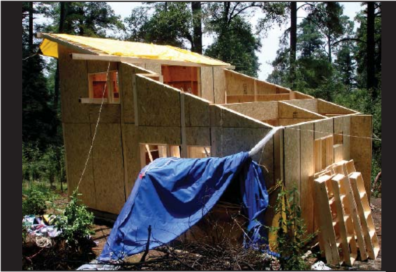
MONTAJE Quinta etapa; Fijación de Conectores y Paneles Horizontales en interiores y cubierta:
