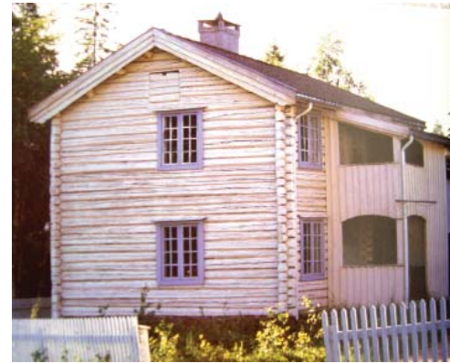
Fig. 2. Ejemplo de construcción en madera en Estados Unidos
