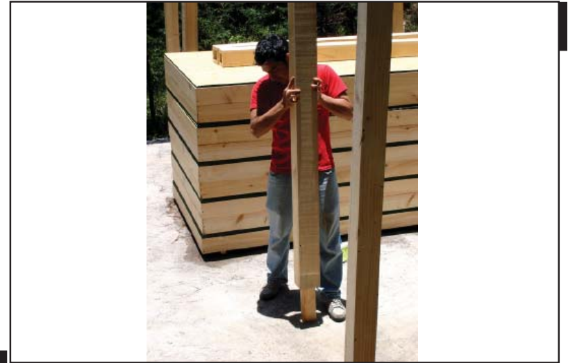
MONTAJE Primera etapa; Fijación de Conectores verticales a varillas roscadas coladas en sitio:
