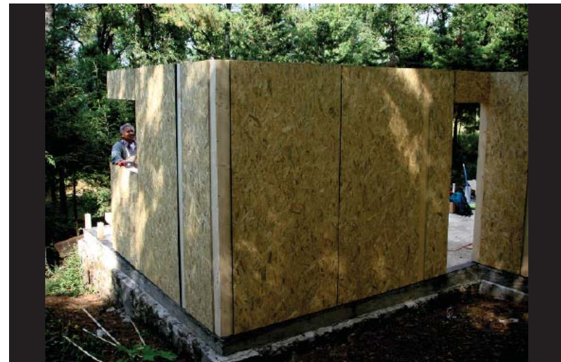
MONTAJE Tercera etapa; Fijación de Paneles verticales interiores, paneles puerta y paneles ventana:
