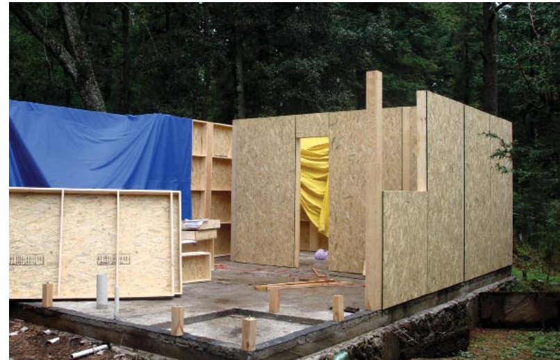
MONTAJE Tercera etapa; Fijación de Paneles verticales interiores, paneles puerta y paneles ventana:
