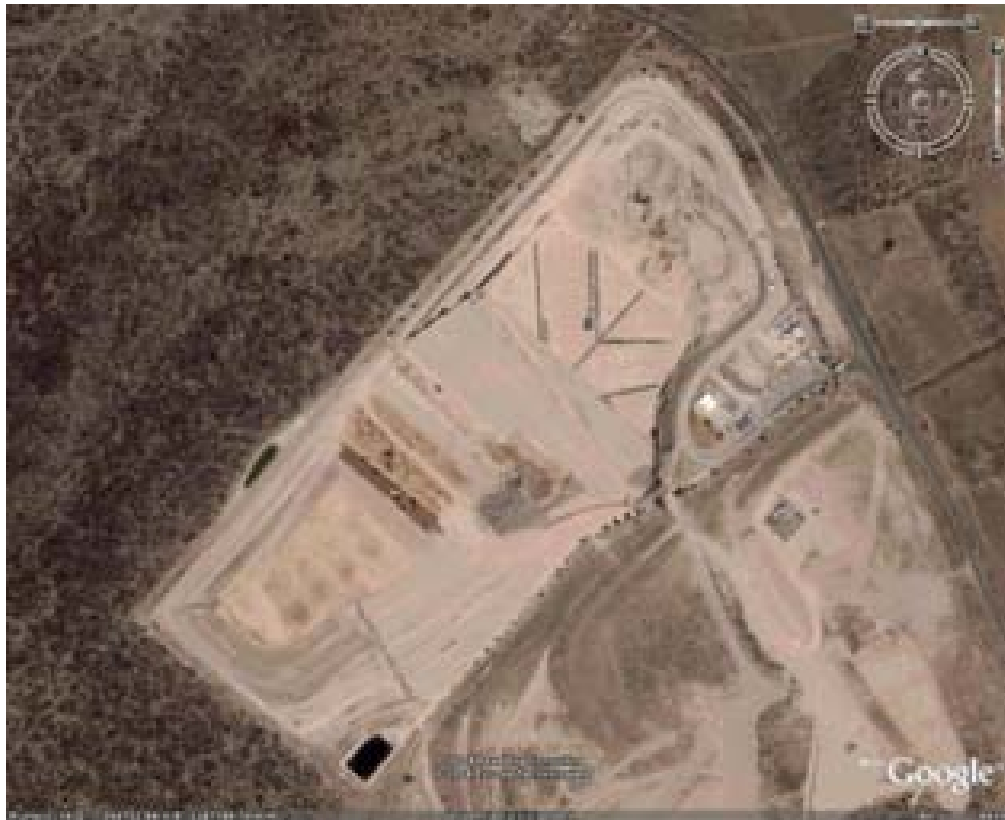
Vista aérea Relleno Querétaro. Fuente: Google Earth (octubre, 2008).
