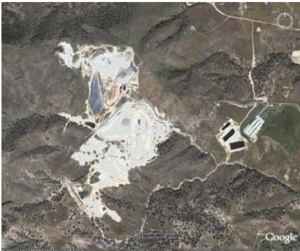
Vista aérea Relleno Picachos. Fuente: Google Earth (octubre, 2008).
