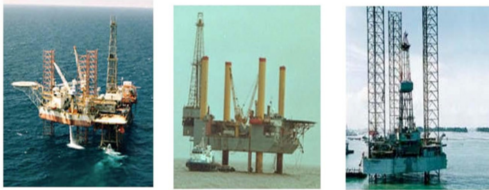
Figura 4.4 unidades de perforación autoelevables.
