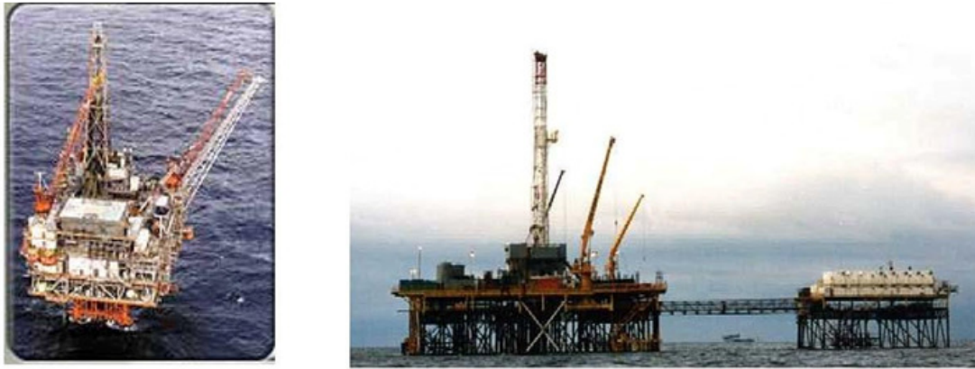
Figura 4.5 plataforma fija autosuficiente.
