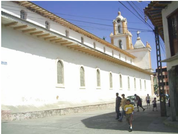
Imagen 4.15: Nos muestra que todos los muros a excepción de la fachada principal están hechos de adobe. Fuente: El autor
