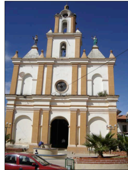
Imagen 4.16: Nos muestra el sistema constructivo hecho con muros de ladrillo y cemento Fuente: El autor
