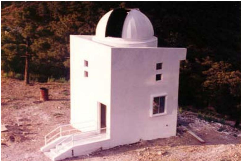
El planeamiento del programa arquitectónico del observatorio de Cananea propone la integración de todos sus elementos dentro de un mismo edificio, lo cual provoca que el calor generado por los niveles inferiores del edificio, (destinados a habitación y servicio), genere perturbaciones de temperatura en el área superior de observación.
