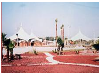
ESTRUCTURA DE MEMBRANA, Feria de la flor, Cuernavaca, Morelos, Fuente: www.tensoestructuras.com/tenso
