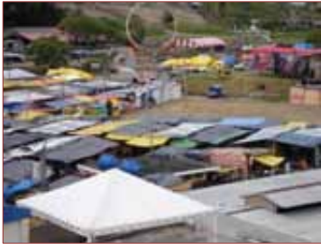
COMPLEJO FERIAL, Estructuras temporales, época de feria, Fuente: EL AUTOR, 2007
