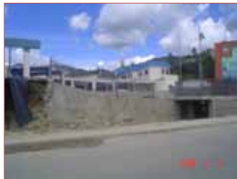
CONSTRUCCION DE UN TEATRO, ubicación en la esquina más conflictiva del complejo, OBRA PARALIZADA, FOTO: AUTOR, 2008
