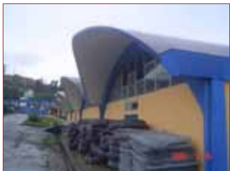
COMPLEJO FERAL, Estructura de Hormigón sin uso, Fuente: EL AUTOR, 2008
