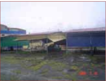
COMPLEJO FERAL, Estructuras abandonadas, Fuente: EL AUTOR, 2008
