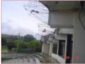
DESTRUCCION DE LAS CUBIERTAS DE LOS ANOS 70, PARA COLOCACION DE LA CUBIERTA DEL TEATRO, TRABAJOS 50%, FOTO, FEBRERO2008
