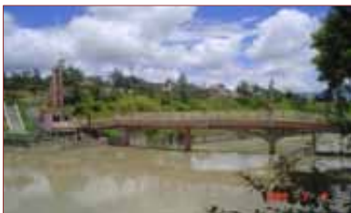
PARQUE LINEAL, Represa de Hormigón, FOTO: AUTOR, 2008
