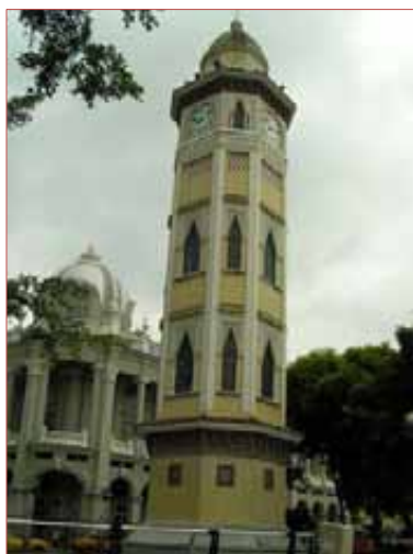
TORRE MORISCA, MALECON2000, FUENTE: imágenes de google/malecon2000.ec
