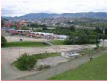
COMPLEJO FERIA, Vista panorámica, Fuente: AUTOR, 2006
