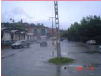
COMPLEJO FERIAL, Av., Salvador Bastante, divide el parque jipiro con el complejo ferial, Fuente: AUTOR, 2008
