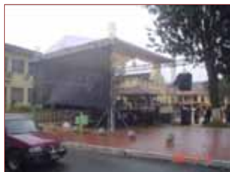
SISTEMA DE TRUSS, Plaza de San Sebastián, Fuente: AUTOR, 2007
