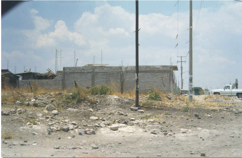
Figura 4. Vivienda cercana a la carretera Querétaro – San Luis Potosí
