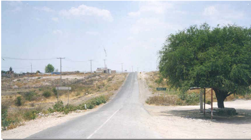
Figura 10. Electrificación sobre Carretera a Juriquilla
