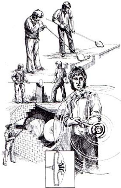
Imagen No.2. Método de Cacquerrai http://www.joostdevree.nl/bouwkunde2/jpgg/glas_alles_over_glas_productie_handmatig_3_cilinders.jpg
