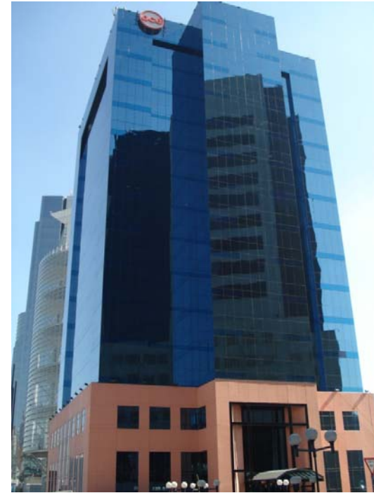
Imagen No. 55. Fachada Poniente. Acceso Principal.
