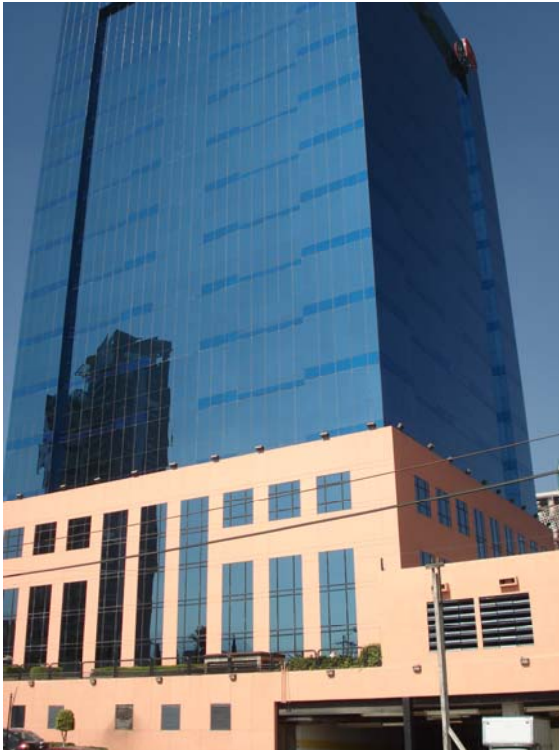
Imagen No. 54. Fachada Sur. Acceso Estacionamiento.
