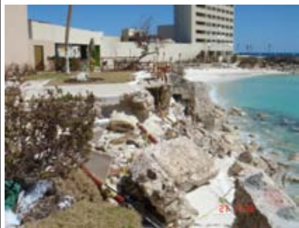
VISTA DE ESCALERAS A ALBERCAS INFERIORES
