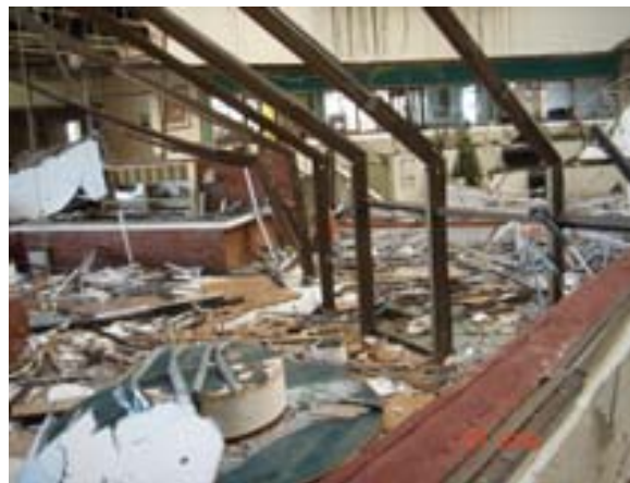
VISTA INTERIOR HACIA ACCESO
