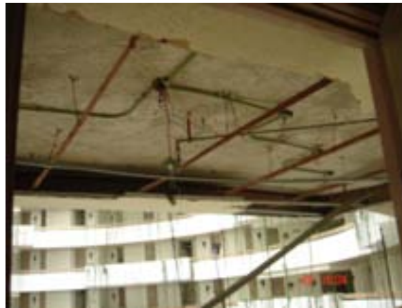
INSTALACIONES ELECTRICAS Y CONTRA INCENDIO
