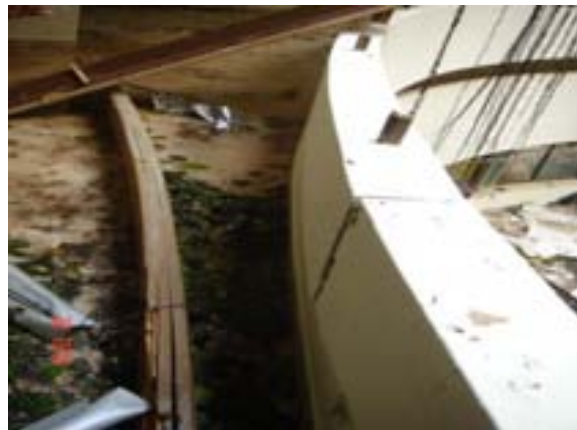
BARANDAL DE PASILLO NIVEL 1
