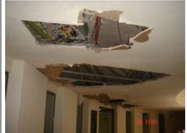
PASILLO NIVEL "C"
