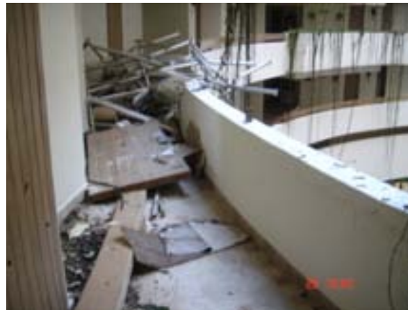
DESECHOS DE DOMO Y CARPINTERIA EN NIVEL 2
