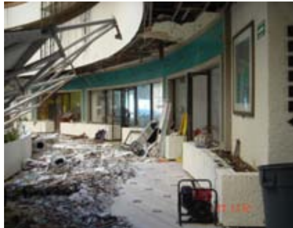
PASILLO DE LOBBY
