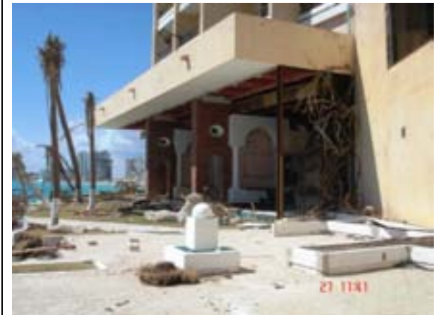
FACHADA POSTERIOR, VISTA AL MAR
