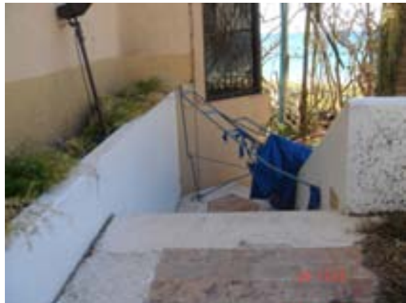
VISTA DE ESCALERAS A ALBERCAS INFERIORES
