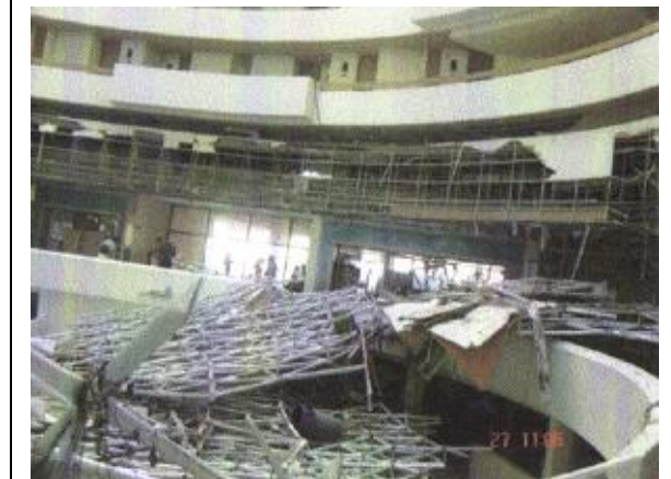
VISTA DE DOMO HACIA ACCESO PRINCIPAL
