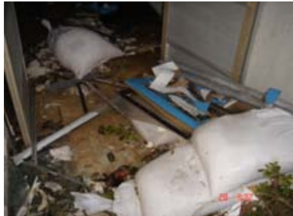
RAMPA DE ACCESO NIVEL "C"
