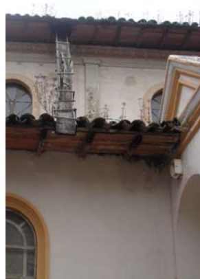
Nótese el uso de un elemento que funciona como canal y daña la imagen del edificio. Autor 2006
