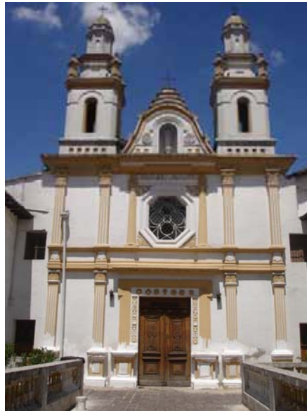
Vista Frontal de la Iglesia. Autor. 2008
