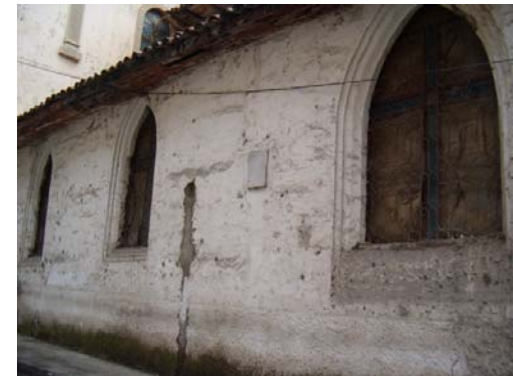
Ventanales del Conjunto de Santo Domingo de Loja. Fuente Autor 2007
