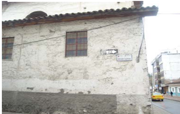
Vista de muro de tapial y sobrecimiento. Autor 2006
