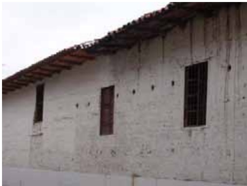
Ventanas rectangulares, convento antiguo. Autor 2006
