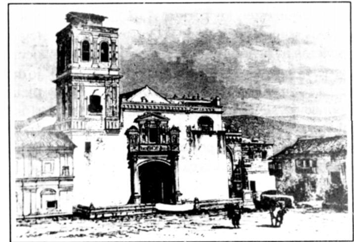
Convento antes de la intervención Italiana (s. XIX)
