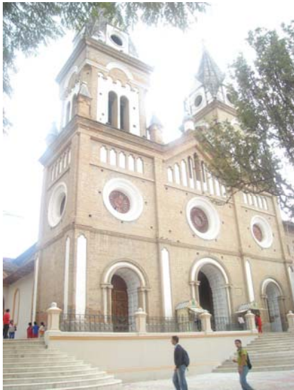
Vista exterior de la Iglesia . Autor 2008
