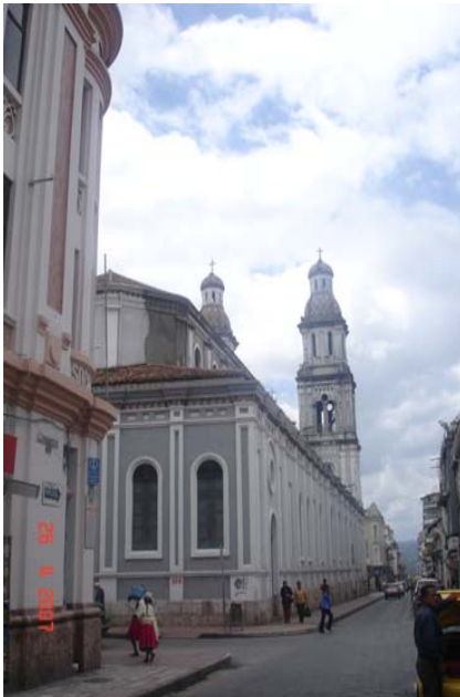
Vista exterior de la Iglesia . Autor 2007
