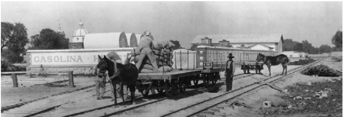
Fig. 202 Imagen de un patio de maniobras en 1929 que demuestra el retroceso posrevolucionario en cuestiones de transporte. Muchas vías destruidas parcial o totalmente fueron utilizadas nuevamente con fuerza motriz animal ante la carestía de material rodante y las pésimas condiciones materiales de los edificios.
