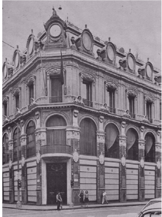
Fig. 267 Joyería la Esmeralda. Proyectada por el Arq. Eleuterio Méndez y el Ing. J. Fco. Serrano (1890-1892) aunque no es posible ligarla directamente con la actividad ferroviaria si es interesante resaltar la intervención de Méndez quien participó en varios proyectos ferroviarios y en este caso logró insertar en su edificio un rasgo distintivo de las estaciones: el reloj.
