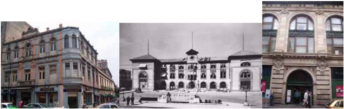
Fig. 302-304 La terminal del Ferrocarril Nacional o estación Colonia al centro tuvo características que serían repetidas en no pocas estaciones en edificios de relevante calidad arquitectónica. La ventana tipo bay window , sus grandes ventanales de medio punto divididos por un entresuelo o la torre central con reloj fueron elementos formales aprehendidos por otros géneros como es el caso de una casa en la ciudad de México sobre 5 de mayo esquina con Bolívar (ventanas bay window ) o la misma casa Boker que utilizó los ventanales con arco de medio punto
