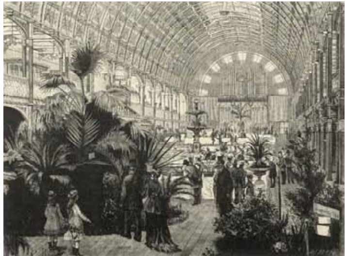
Fig. 212 El Palacio de Cristal de Paxton en la exposición de 1851 promovió el uso de las cubiertas de cristal y acero. Las posibilidades espaciales generadas por su enorme cubierta y la iluminación cenital fomentaron la construcción de techumbres en las terminales europeas de mediados del siglo XIX, para posteriormente introducirse en géneros como los comerciales, de almacenaje, industriales, etc.
