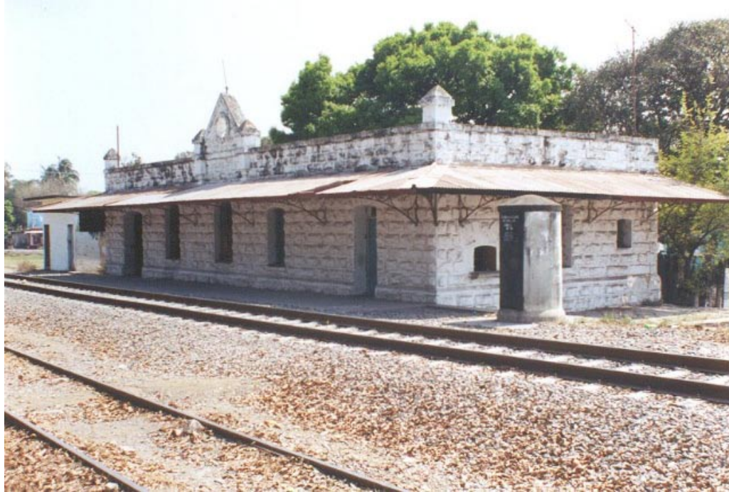
Fig.149 Las estaciones con techo plano con una cubierta a manera de alero fue otra de las tipologías utilizadas. Una de las formas para sostener dicha techumbre era con ménsulas que podían ser de madera o de metal que sin lugar a dudas les confirió un aspecto menos sobrio que las vistas anteriormente. En la imagen los Ídolos, Veracruz. (2002)
