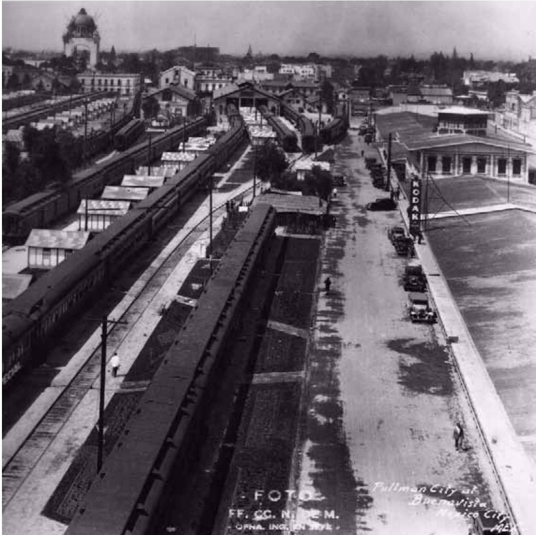
Fig. 165 Vista panorámica de la ciudad Pullman de Buenavista, al fondo el monumento a la Revolución y un plano más enfrente el edificio principal de la estación del Central. En primera instancia los largos convoyes paralelos a las construcciones especializadas para los fletes, ubicados en las pequeñas casetas. Circa 1929.
