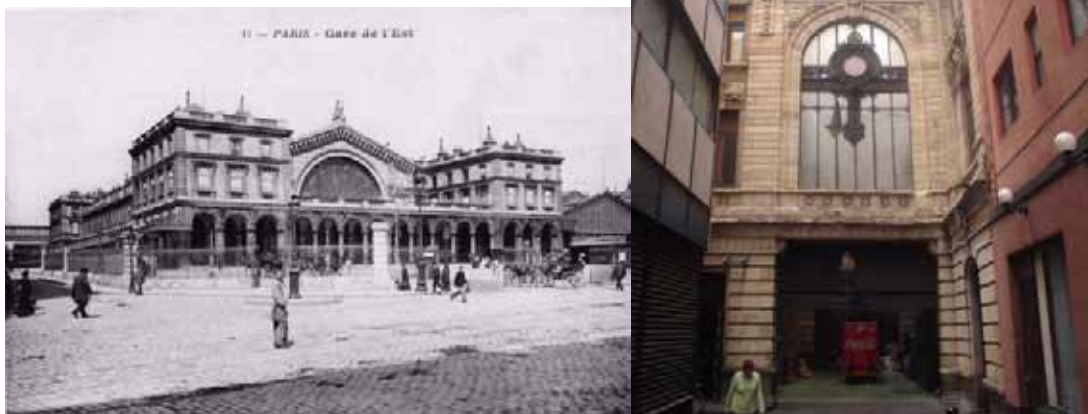
Fig. 300-301 Estaciones como la del Este en París lograron impactos formales no sólo en las estaciones, en México un ejemplo del pasaje comercial de la Segunda Cerrada de 5 de Mayo, repite el esquema de un enorme ventanal que enmarca una gran cubierta de cristal y acero, espacio característico de las grandes terminales ferroviarias.
