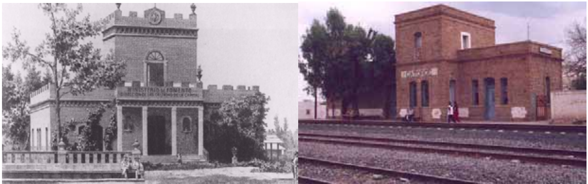
Fig. 305-306 Las coincidencias formales y su paulatina síntesis volumétrica comenzó también a preferirse en algunos géneros con actividades francamente utilitarias. En este caso el edificio de la Dirección de Calzadas frente al monumento a Colón, construido en 1880, mantiene rasgos muy similares a la estación de Catorce y Wadley en San Luis Potosí. A pesar de que estas últimas fueron construidas en la segunda década del siglo XX vale la pena notar su analogía.
