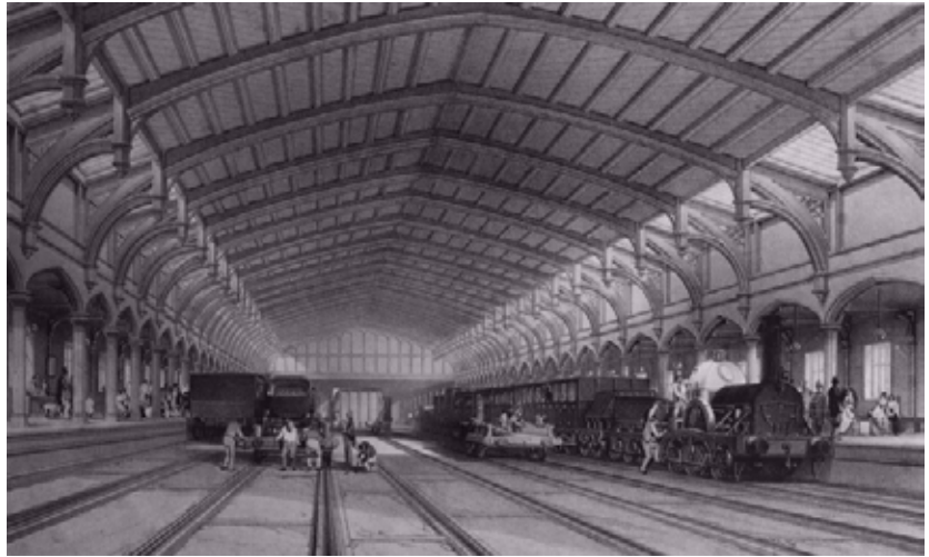
Fig. 214 Interior de la cubierta original de I. K. Brunel de la Meads Station en Bristol Inglaterra proyectada entre 1839-1840. Este diseño demuestra la anticipación funcional-constructiva que la actividad ferroviaria y el género arquitectónico tenía sobre los demás. Las condiciones móviles y necesidades prácticas del transporte tenían que reflejarse en sus edificios, ejemplos tangibles de una racionalidad implícita, lo que demuestra un adelanto de prácticamente un siglo a lo estipulado por las teorías de la Bauhuas y Le Corbusier.
