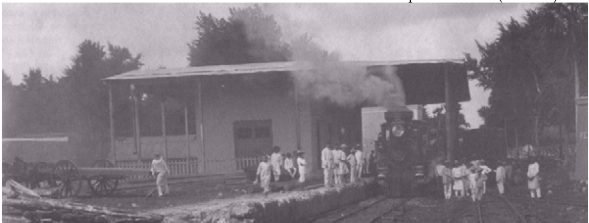
Fig. 156 Esta estación de la línea de Mérida a Peto presenta características similares a la anterior, con la cubierta que se extiende hasta las vías. Estos modelos fueron raramente reproducidos en otro punto del territorio. A pesar de tal singularidad, no podemos afirmar que haya sido la única solución en la península ya que también existieron tipologías diversas, mismas que se diversificaron a partir de la unión de todas las líneas yucatecas. (F. S. XIX)
