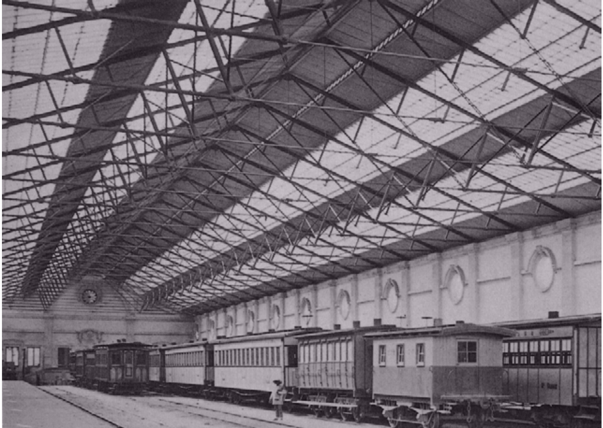
Fig. 192 Esta imagen de la cubierta de la estación de Buenavista del Ferrocarril Mexicano logra retratar la cristalización del espacio más característico de las grandes estaciones, erigidas gracias a la utilización del hierro y el vidrio que en definitiva iniciaron la revolución arquitectónica, al obligar a los replanteamientos teóricos de la arquitectura. (1880-1890)
