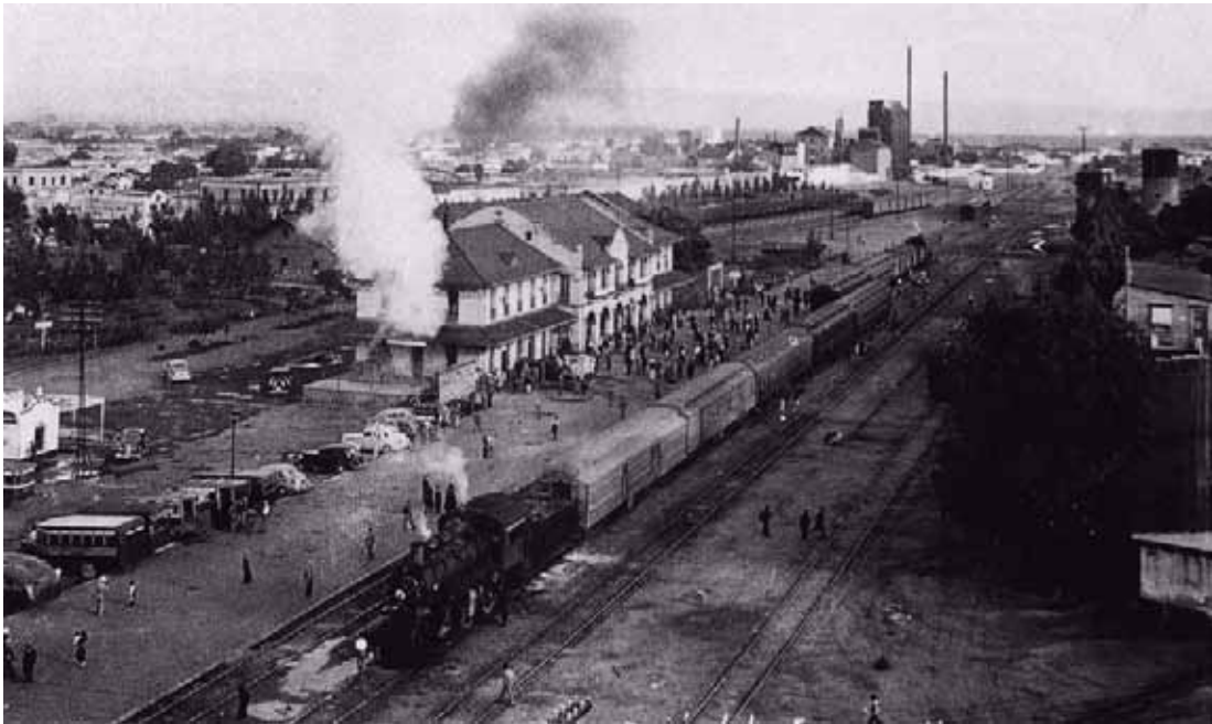
Fig. 166 Con esta foto elevada de la importante estación de la ciudad Aguascalientes se advierte perfectamente el edificio principal y el gran patio que traduce la actividad comercial de tan cardinal punto ferroviario. Aunque no aparece el área de carga y descarga de mercancías, las dimensiones del patio de maniobras frente al inmueble, y su extensión al fondo no deja dudas de la existencia del complemento. Circa 1940.
