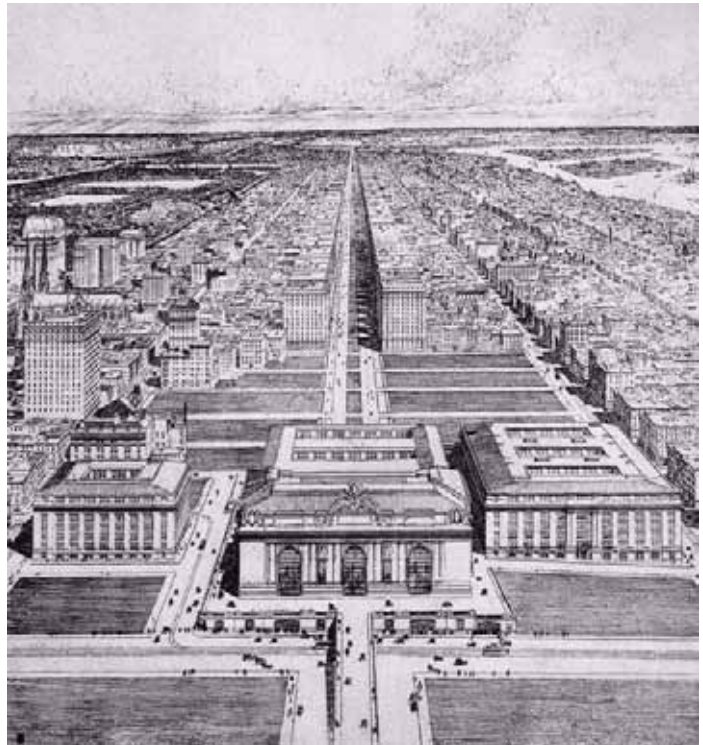
Fig. 84 La posibilidad de reducir espacios con la electrificación de los sistemas de locomoción, provocó la reducción de áreas en la superficie, logrando que importantes estaciones pudieran erigirse en el corazón de las ciudades, un ejemplo fue la estación central de Nueva York (1905) aquí en la imagen.
