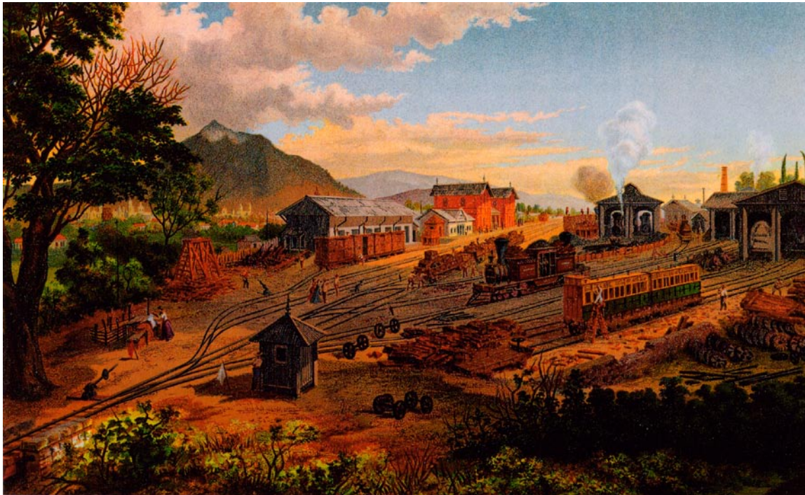
Fig.139 La litografía panorámica de la estación de Orizaba realizada por Casimiro Castro logra darnos una idea muy clara de los diferentes componentes de un estación intermedia de relevante importancia al integrar talleres y estación de mercancías dentro de sus límites. A pesar de no ser un empalme como Apizaco, las necesidades de las empresas obligaban a construir conjuntos con estas características en puntos estratégicos de las líneas. Circa 1880. (1920)
