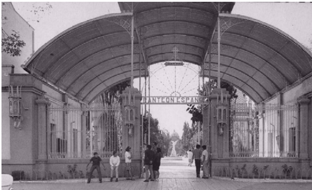
Fig. 282 La entrada al Panteón Español (1891-1892) atribuido a los Arqs. Ignacio y Eusebio de la Hidalga denota el pleno conocimiento del fierro en la construcción. También es evidente la analogía con las cubiertas de las estaciones, incluso con los grandes almacenes.
