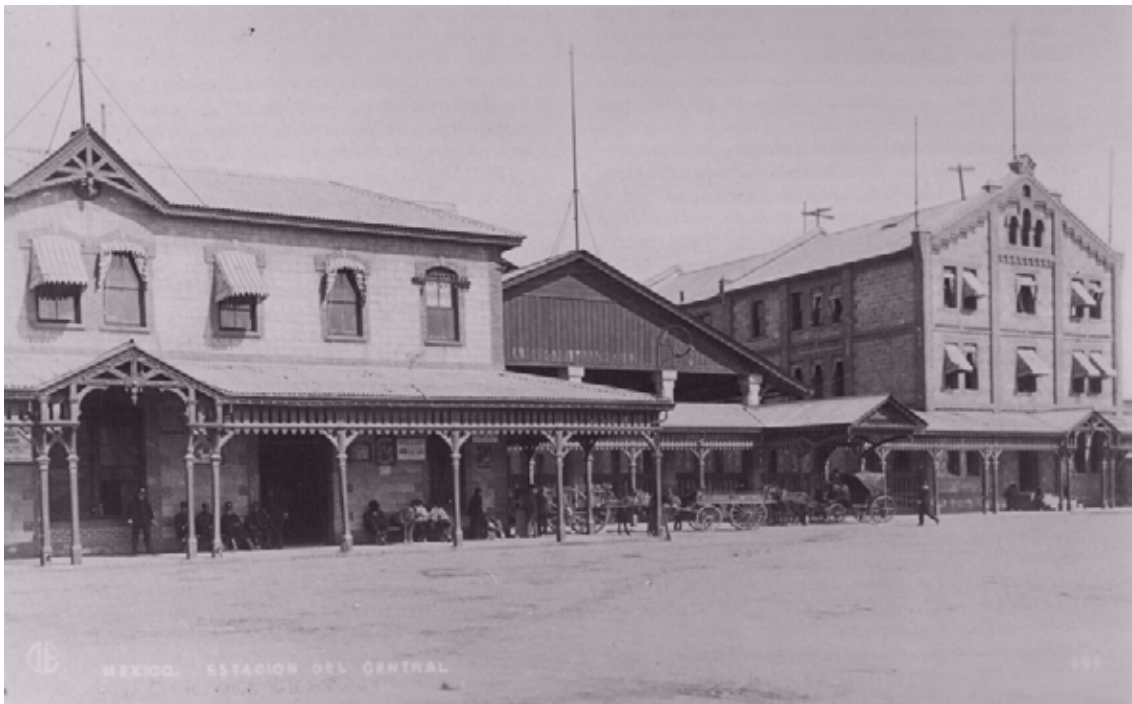
Fig.123 La claridad arquitectónica era fundamental para el buen funcionamiento en las estaciones. En la estación del Central en Buenavista esta premisa se resolvió mediante al división de funciones con volúmenes separados, cada uno con un lenguaje propio que hacía inconfundible la actividad adentro realizada. En la foto en la parte central se observa la cubierta para los trenes, resguardado por las llegadas y salidas en forma separada, y en el edificio principal (al fondo) las oficinas de la compañía. Circa 1929.
