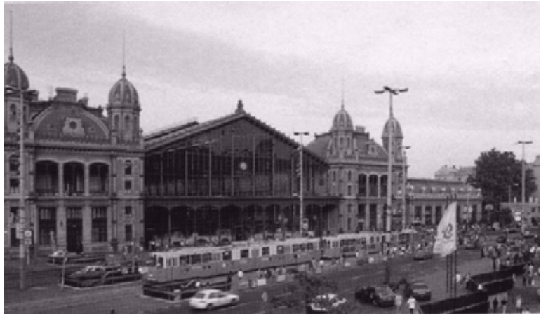
Fig.74 La utilización del acero provocó un cambio en la percepción estética hacia la nueva arquitectura. Ante esta situación los arquitectos, pero sobre todo los ingenieros lograron introducir el material con resultados importantes como la estación Budapest Nyugati de Alfons Serres en la que también intervino Eiffel. (1873-1877)
