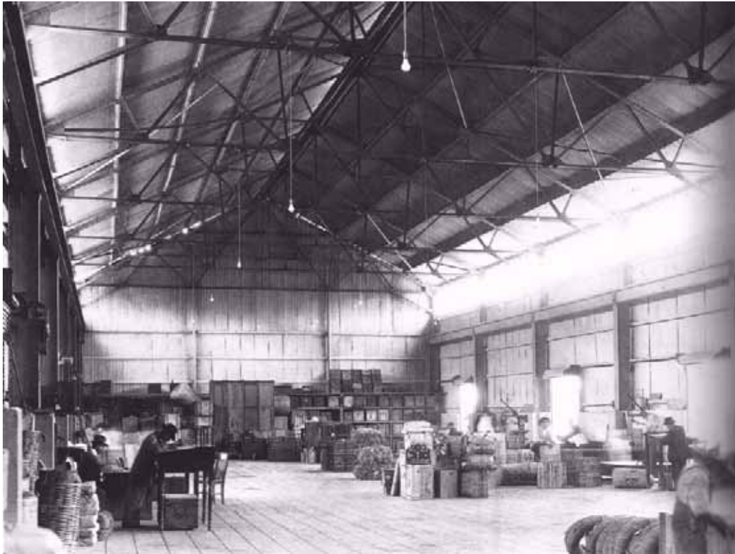
Fig. 263 Las primeras estaciones ferroviarias definitivamente no lograban satisfacer los preceptos estéticos arquitectónicos que les habían inculcado en las academias a los arquitectos nacionales. Esta foto de la bodega del express del Ferrocarril Nacional en la ciudad de México nos da una idea de la sencillez de estas primeras construcciones. (Foto 1929)
