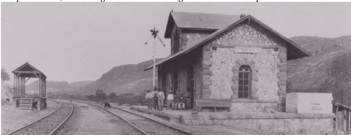
Fig. 144 Imagen correspondiente a la estación Hércules, con la variante del piso superior para la vivienda del jefe de estación. Frente al edificio, un pequeño muelle construido precariamente para facilitar las maniobras de carga y descarga de mercancías. Circa 1929
