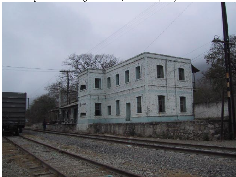
Fig. 152 La importancia del asentamiento y el flujo de pasajeros determinaba la capacidad de los hoteles insertados en los mismos edificios de las estaciones, esta imagen de la estación Las Palmas en San Luis Potosí y la anterior de Oriental nos clarifican dichas disposiciones. (2002)
