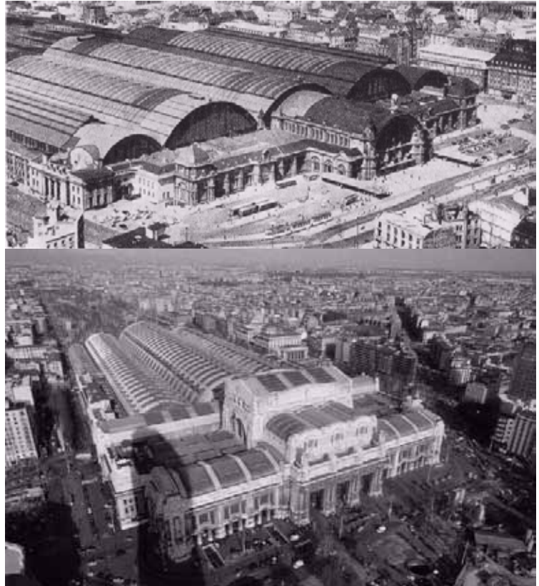
Fig.80-81 El acelerado crecimiento de los flujos provocó la introducción de más vías de entradas y salidas para los trenes. Los edificios tuvieron que acoplarse a las nuevas necesidades y su monumentalidad fue destacada. En las imágenes es posible observar el mencionado crecimiento y sus soluciones espaciales. Arriba, la Hauptbahnhof, de Frankfurt; abajo, la estación central de Milán. Finales del S. XIX inicios del XX.
