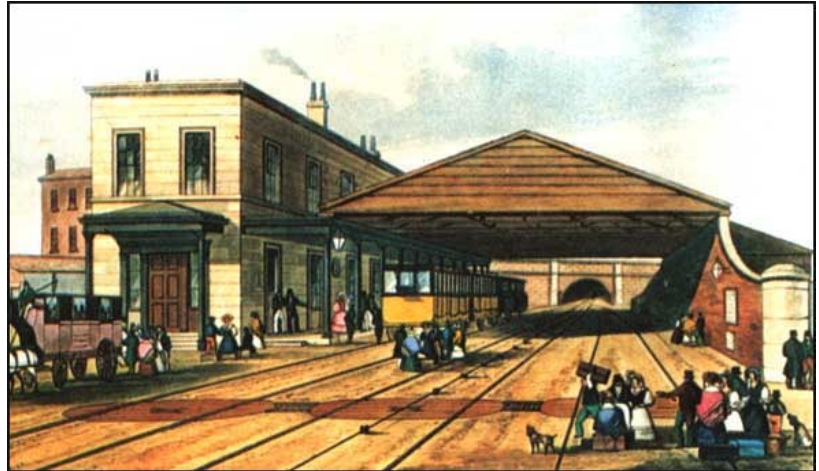
Fig. 52 Considerada como la estación primigenia en el mundo (1829-1830), Crown Street denotaba su carácter ferroviario por la cubierta de madera que protegía tanto a las mercancías, personas y máquinas de las inclemencias del tiempo. El edificio que albergaba las oficinas y taquilla no tenía las cualidades formales que posteriormente habrían de diferenciar a la arquitectura ferroviaria con los demás géneros arquitectónicos.
