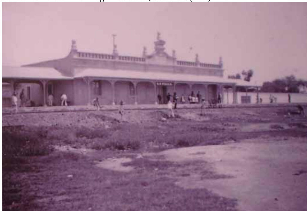
Fig. 150 El uso de postes (metálicos o de madera) en lugar de las ménsulas otorgaron a las estaciones que manejaron tal procedimiento una imagen particular, sin embargo se encuentran agrupadas con las arriba mencionadas. Foto de la estación La Villa en la ciudad de México.
