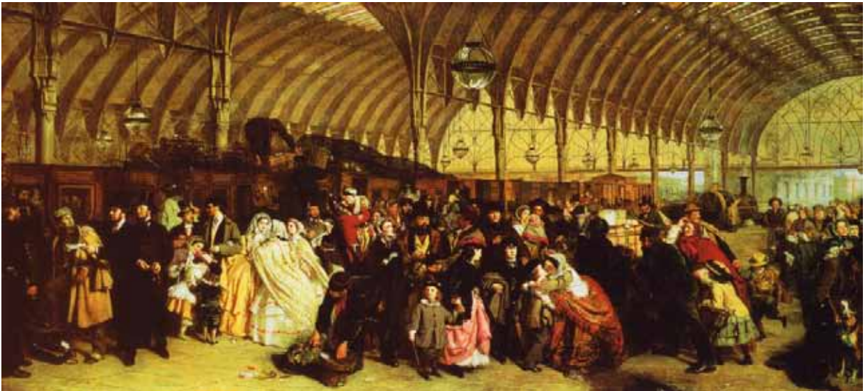
Fig. 216 Imagen del cobertizo de una estación inglesa en 1862. Nótese la similitud del esquema y forma de la techumbre con el Palacio de Cristal de Paxton. Estos grandes espacios resultantes, iluminados por luz natural cenital provocaron una revolución arquitectónica al desencadenar una enorme gama de posibilidades funcionales. El apoyo del techo sobre esbeltas columnas o pilares metálicos facilitaba el desarrollo y división de recintos complementarios que enfatizaban el utilitarismo de estos edificios.
