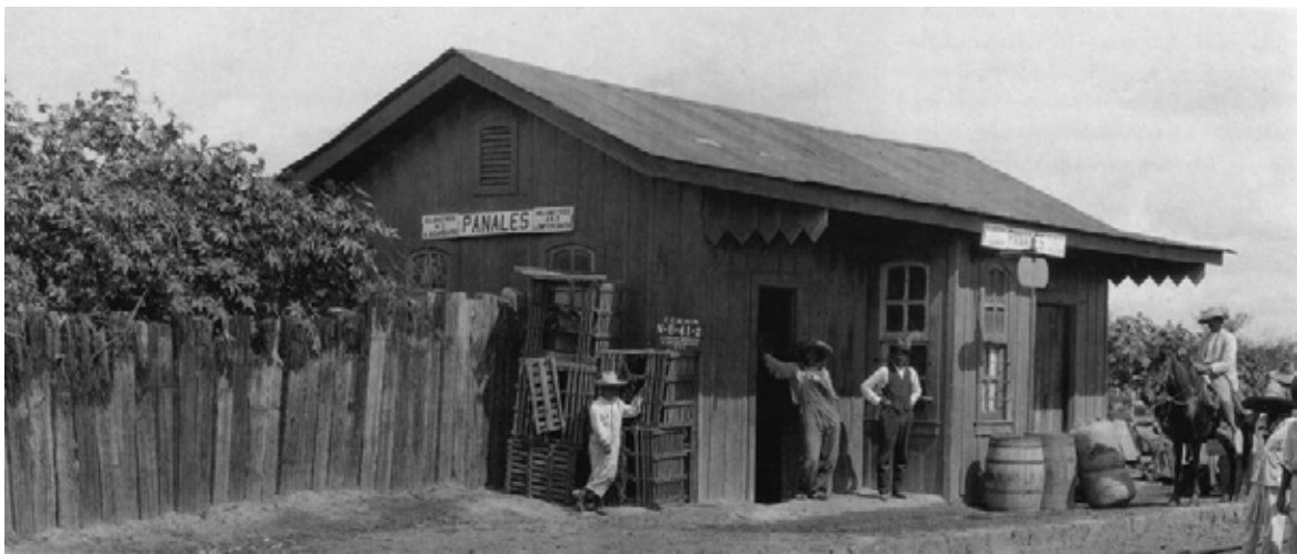
Fig.135 Esta imagen de la estación Panales en Guanajuato podría resumir la mínima unidad de una estación intermedia. Es posible leer perfectamente sus componentes con el mirador del jefe de vía, una pequeña sala de espera y una diminuta bodega. La calidad de los materiales en este caso denota su poca importancia dentro de la línea, sin embargo así como esta, pulularon a la par del tendido de las vías dentro del territorio nacional. Circa 1929.
