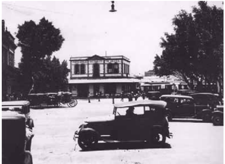
Fig. 48 Poco a poco la imagen de progreso de los ferrocarriles fue usurpada por los vehículos, una inadecuada planeación para las comunicaciones terrestres llevarían al colapso del sistema.
