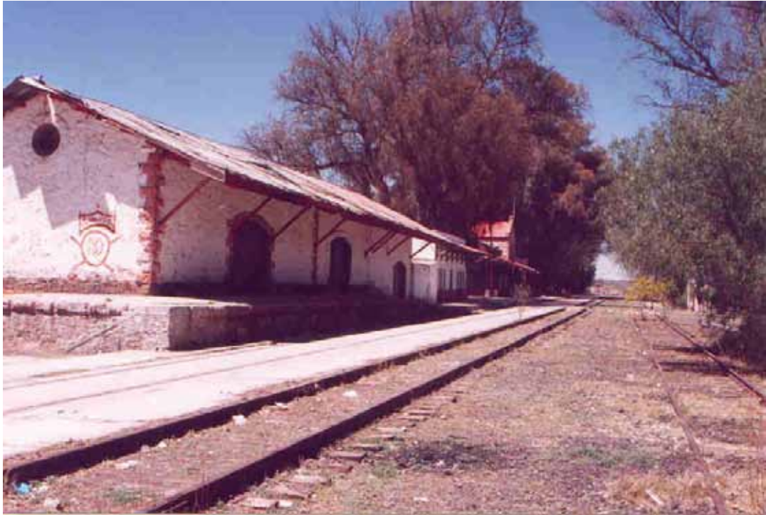
Fig.127 Los muelles junto con la sobriedad de sus formas fueron las características más importantes para diferenciar los edificios destinados a la carga de productos y la de pasajeros. En esta foto (2002) de la estación de Dolores Hidalgo podemos observar el inmueble para carga en un primer plano con el muelle circundándolo y al fondo la construcción de pasajeros, más elaborada pero sin los elementos propios para la carga y descarga de mercancía.
