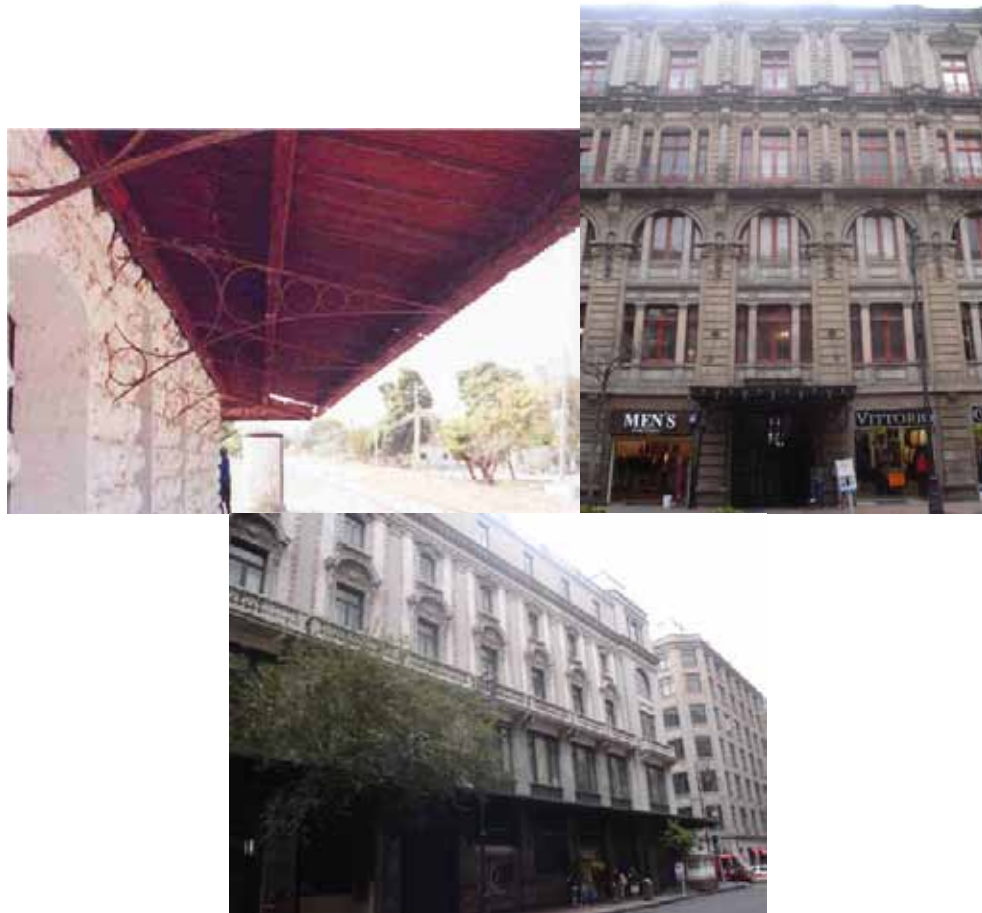
Fig. 311-313 La relación de las estaciones con el exterior se establecía además de sus fachadas y sus elementos constitutivos por una protección para los usuarios y no usuarios constituido por un alero sostenido por esbeltos pilares o ménsulas de diversos diseños. Algunos edificios urbanos propusieron tales elementos en sus portadas que significaron un aporte no sólo a su funcionamiento, sino a su relación con la calle y los peatones incluso antes de penetrar en su interior. La primera foto corresponde a un detalle del cobertizo de la estación Los ídolos, Veracruz, la central al edificio París sobre 5 de mayo, igualmente que el último en esquina con Bolívar.
