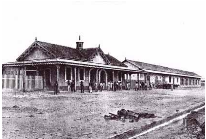
Fig.108 Esta litografía de la estación de Veracruz en la década de los 60s del siglo XIX logra darnos una clara idea del carácter provisional de las primeras estaciones. Sin embargo, también se puede apreciar el cuidado en el aspecto de estos edificios que a pesar de la utilización de materiales provisorios no significaba un problema arquitectónico. La idea de que la funcionalidad no se contraponía con los preceptos estéticos se hace patente desde la entronización de la arquitectura ferroviaria dentro del territorio.
