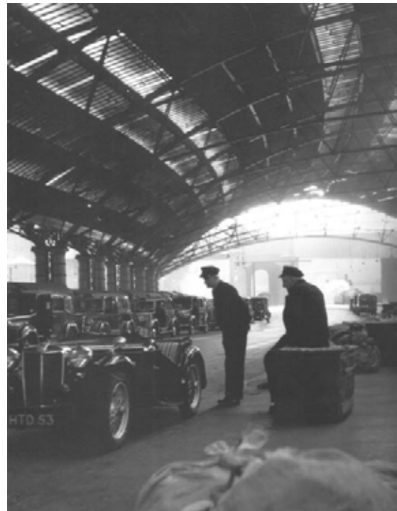
Fig. 56 La cubierta de la estación de Lime Street (1867-68) que aparece en la fotografía fue la precursora de las grandes cubiertas metálicas que desencadenaría una revolución tecnológica en la arquitectura ferroviaria y que el mismo sistema se encargaría de propagar por el mundo.
