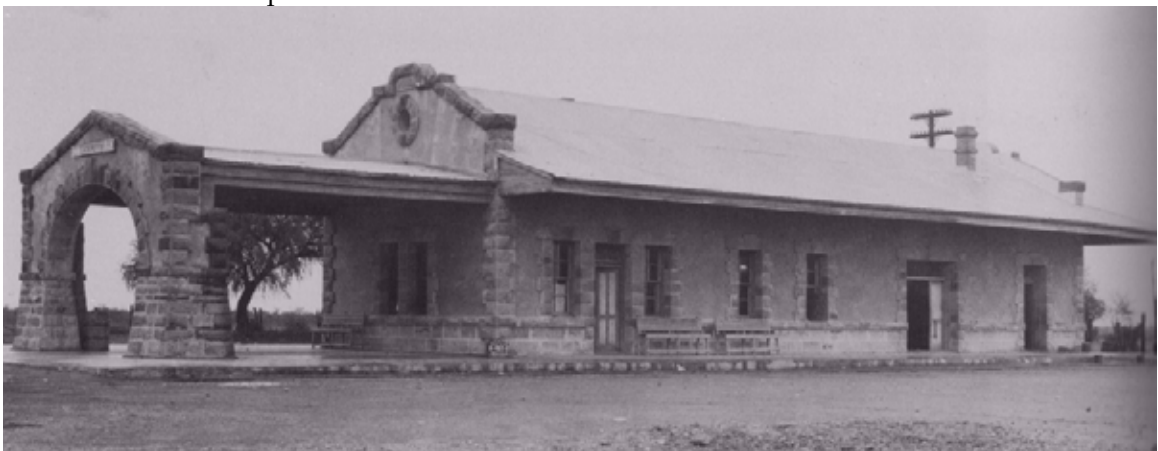
Fig. 146 Este modelo con evidentes influencias del sur de los Estados Unidos se diferencia del anterior por la masividad de los apoyos de la cubierta de la sala de espera, sin embargo como es evidente sus rasgos generales son análogos. Circa 1929.
