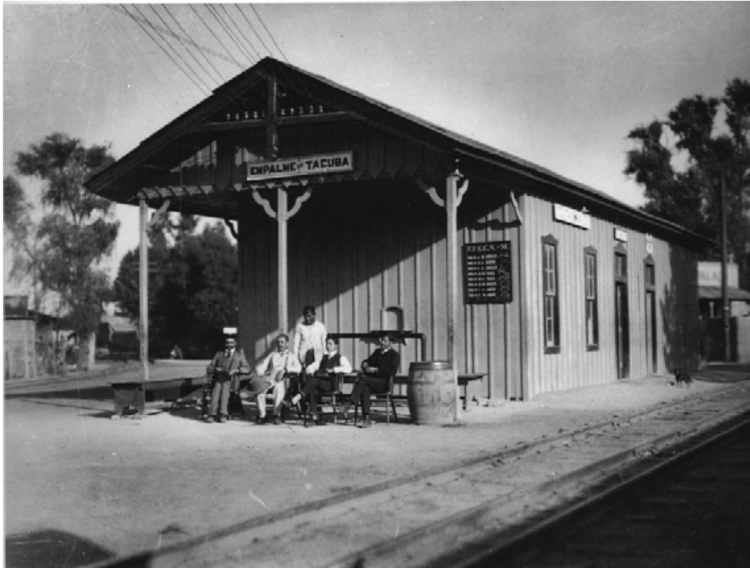
Fig.140 El hecho de que las estaciones intermedias tuvieran talleres, instalaciones para carga o fuesen empalmes no era sinónimo de grandes proporciones como lo demuestra el Empalme Tacuba en 1920, pequeño edificio que sin lugar a dudas logró satisfacer las necesidades del sistema.
