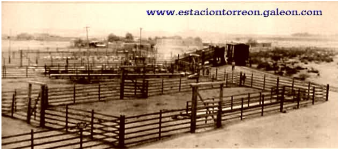
Fig.126 Sin lugar a dudas la arquitectura ferroviaria fue diversa debido a las especializaciones que demandaban las actividades del transporte. Tal variedad se logró observar más claramente en los edificios destinados al traslado de mercancías. Un ejemplo de ello es la imagen de los corrales para ganado en la estación de Torreón. Circa 1900
