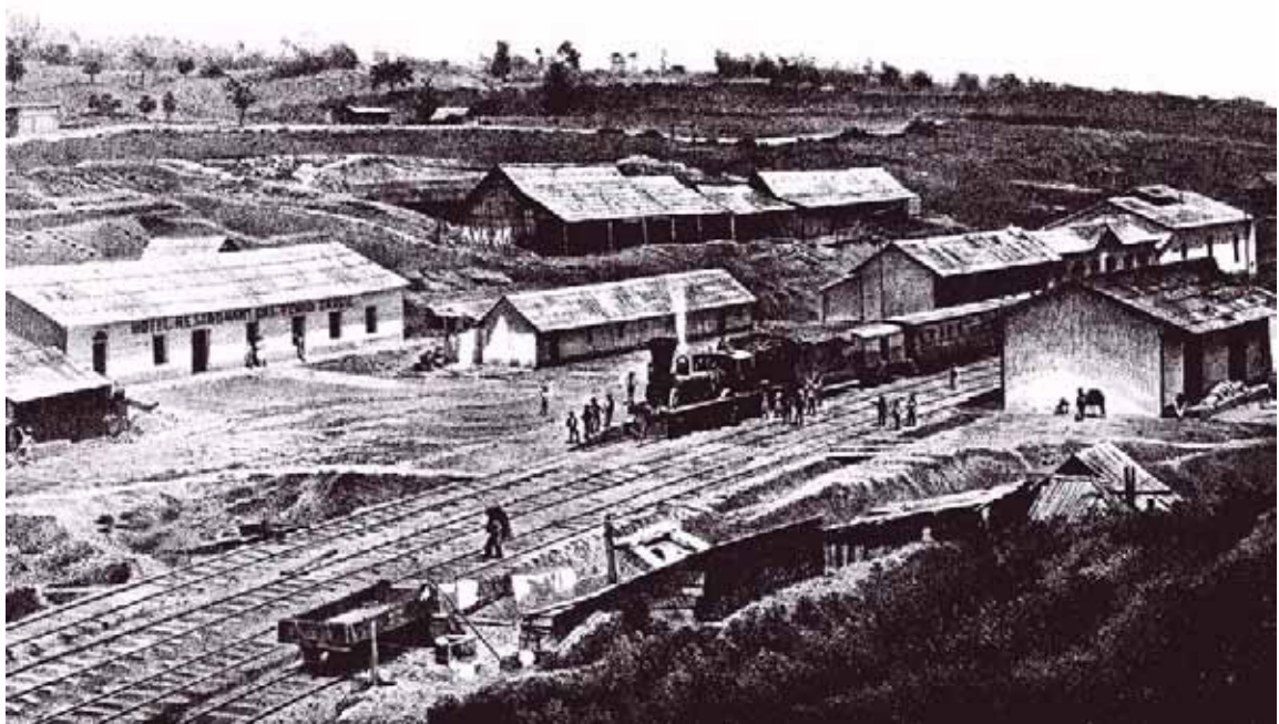
Fig.141 Desde las primeras estaciones construidas dentro del territorio fue utilizado el modelo lateral establecido en Crown Street en los albores de la era ferrocarrilera. Tal disposición apegada al reglamento fue repetido en todas las empresas, incluso en varias estaciones terminales. La imagen de la estación Boca del Monte del Ferrocarril Mexicano, logra confirmar lo establecido anteriormente. Circa. 1880.
