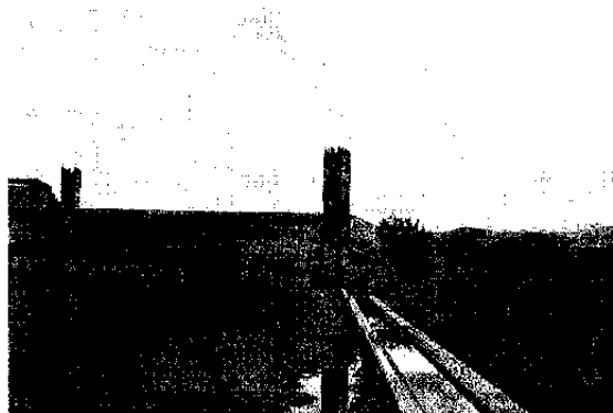
G6.47 Casa de pozo y su torre. El bebedero en frente.
