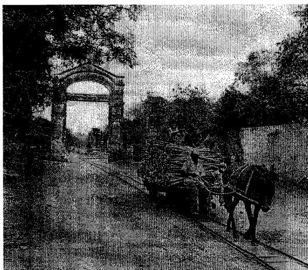
G4.51 Plataforma sobre rieles Decauville (Foto: H.Suaste)
