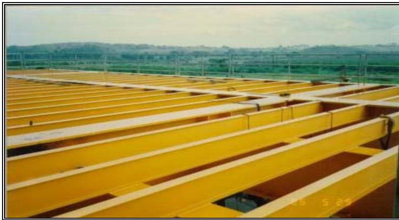
*Fig.6 Sistema de piso. Traves principales y secundarias.*
