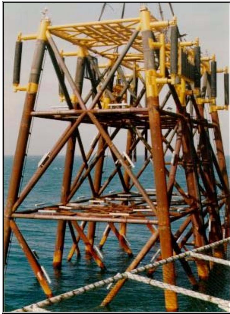
*Fig.8 Subestructura con accesorios durante posicionamiento vertical.*
