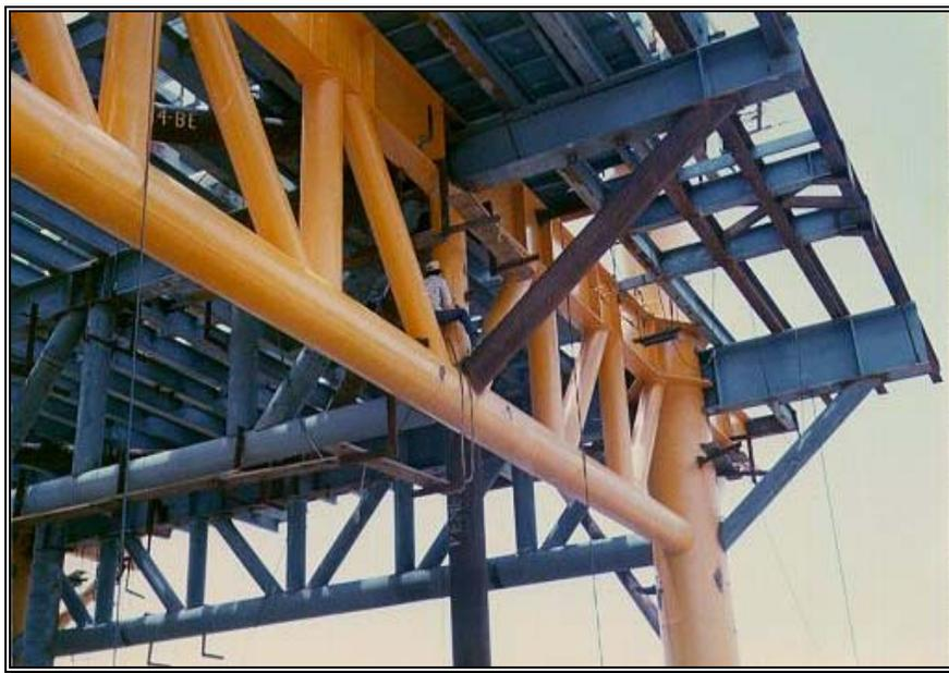
*Fig.7 Armaduras de refuerzo en travesas principales.*
