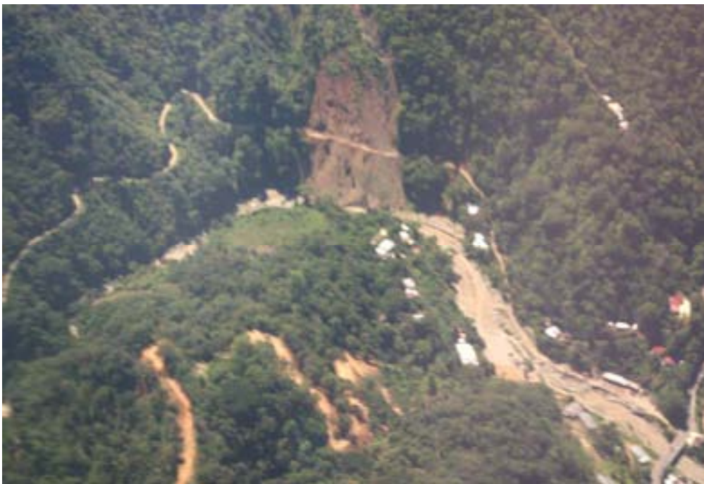
Fig 5.2b Parte de la cuenca del río Coatán, donde se observa la falla de un talud
