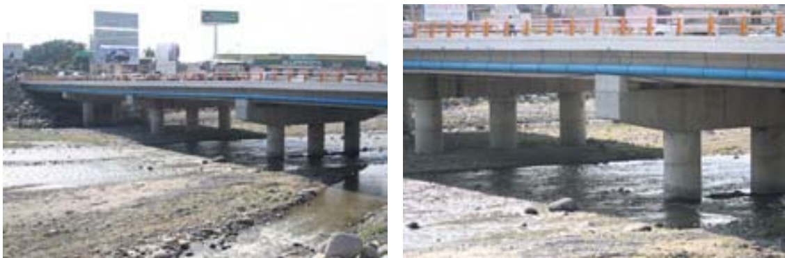
Fig 3.6 Fotografías del puente Coatán (Febrero del 2006)
