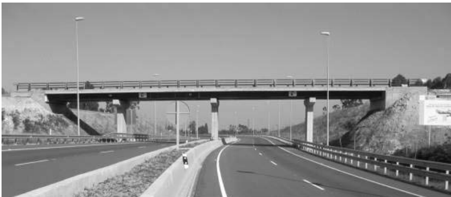
El Puente de la autovía del Cantábrico
