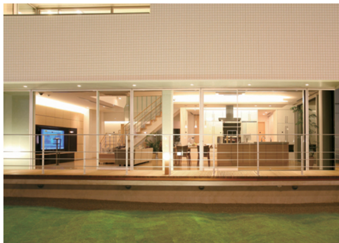
Fig. 15. Vista exterior Vivienda Eco & Ud house.
