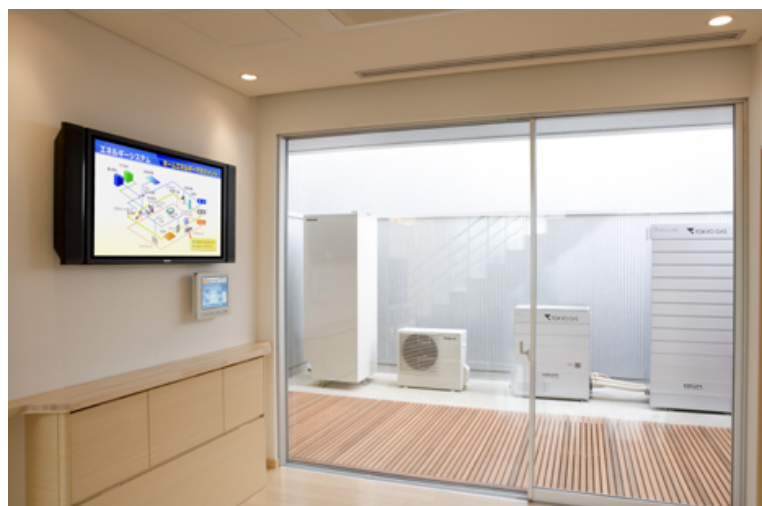
Fig. 10. Vivienda Eco & Ud house.
