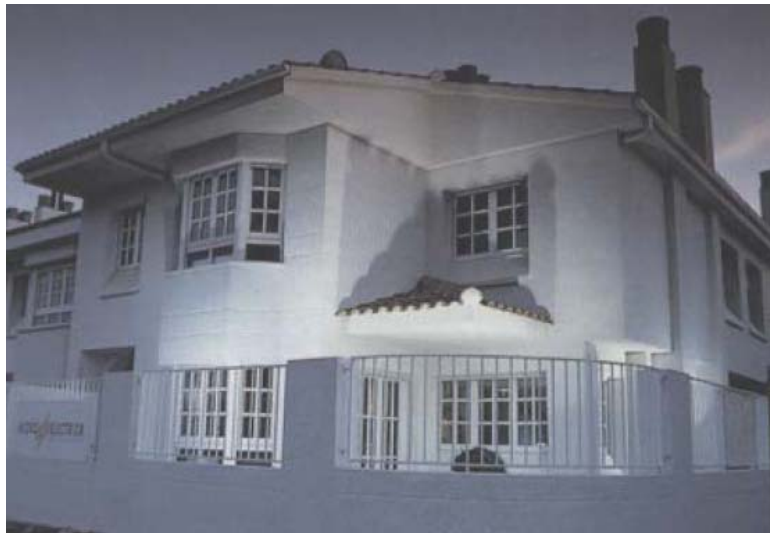
Fig. 4. Fachada de vivienda domótica en España.
