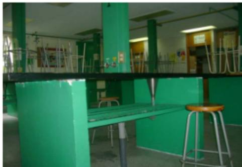
Foto No. 29.- Laboratorio remodelado con una columna sobrepuesta al centro de cada mesa de trabajo desde donde se lleva a cabo la alimentación de agua, gas, y energía eléctrica a estas de manera más sencilla.
