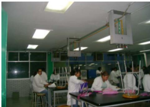
Foto No. 28.- Laboratorio original con alimentación de gas, agua y energía eléctrica, por medio de torretas de manera aérea mediante extensiones. Este tipo de torreta permite la visual de los alumnos hacia el pizarrón y el control del profesor sobre estos.
