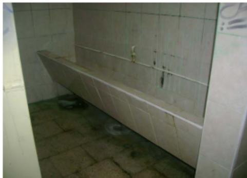
Foto No. 24.- Canal hecho en obra de concreto armado y con acabado de loseta, que opera como mingitorio, en los núcleos sanitarios de estudiantes varones.
