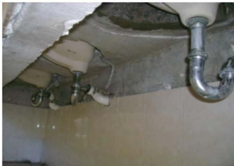
Foto No. 21.- Seccionamiento en la tubería hidráulica de los lavabos por mueble. La tubería de la instalación sanitaria es de Fo. Galvanizado.
