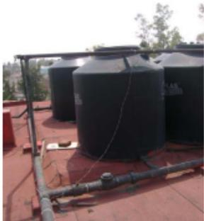
Foto No. 12.- Juego de válvulas que controlan la entrada y salida de agua potable por la misma columna.
