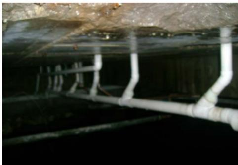
Foto No. 16.- Tubería sanitaria de PVC, semi nueva y en buen estado.
