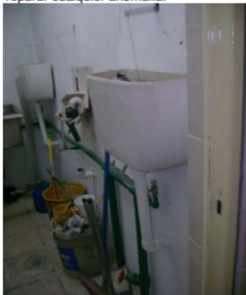
Foto No. 19.- Instalación de las cajas de los inodoros a 1.20 m. de altura.
