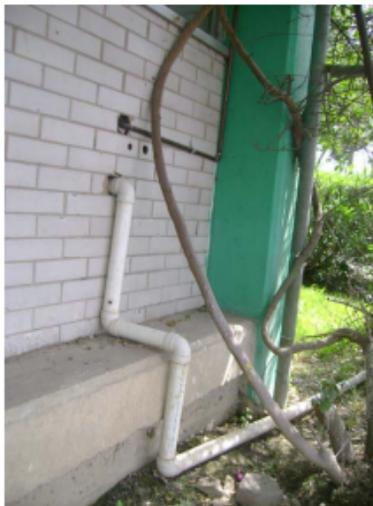
Foto No. 33.- Instalación hidro-sanitaria que da servicio a una tarja adicional ubicada en el edificio "A" las tuberías son de cobre tipo m. y PVC respectivamente.
