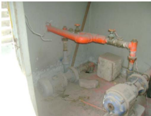
Foto No. 7.- Cuarto que aloja el equipo de bombeo duplex, en donde se observan todos los elementos que intervienen para su funcionamiento.
