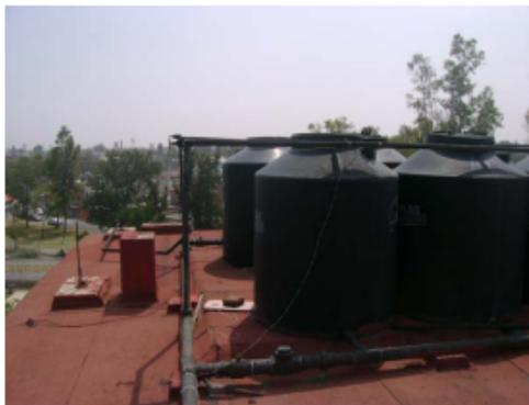
Foto No. 49.- Azotea del edificio "D" que no cuenta ni con pretiles, ni con bajadas de agua pluvial, por lo que el agua de lluvia cae libremente.
