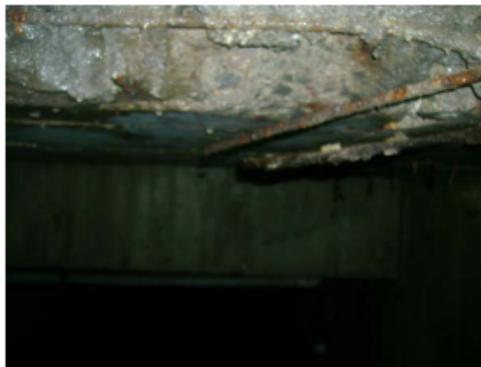
Foto No. 17.- Tubería hidráulica de fierro galvanizado, que alimenta los núcleos sanitarios de estudiantes ubicados en el edificio "D" del Plantel
