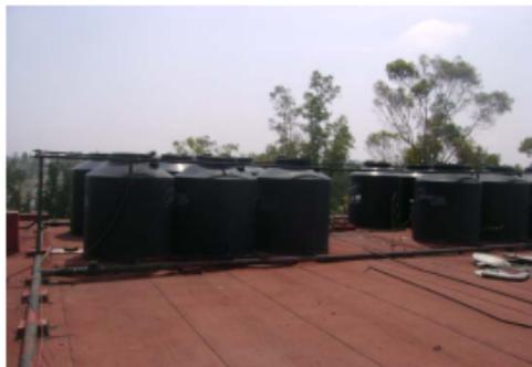
Foto No. 13.- Tinacos de 1100 lts ubicados en la azotea del edificio "D" del Plantel.
