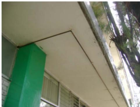
Foto No. 32.- Tubería de cobre tipo m. que alimenta a muebles nuevos ubicados en el edificio "A" de administración.
