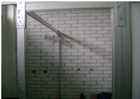
Foto No. 39.- Área de regaderas del núcleo sanitario para mujeres, en condiciones inservibles.
