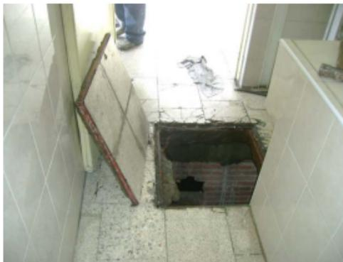
Foto No. 14.- Registro para acceder al sótano del edificio "D" en donde se encuentran alojadas las instalaciones hidro-sanitarias de los núcleos sanitarios para estudiantes.
