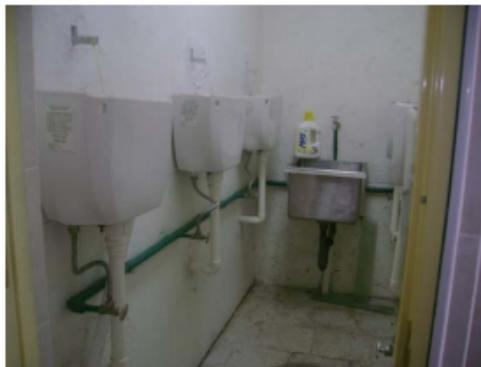
Foto No. 20.- Ducto de instalaciones hidro-sanitarias, con tarja en el interior, para facilitar el aseo del núcleo sanitario y del edificio.
