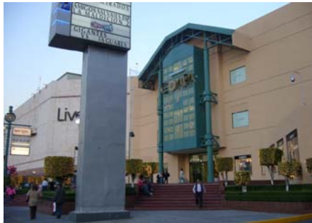
Fotografía toma a un lado de Galerías Coapa en frente de Peri Coapa ubicados en la avenida canal de Mira-montés.
