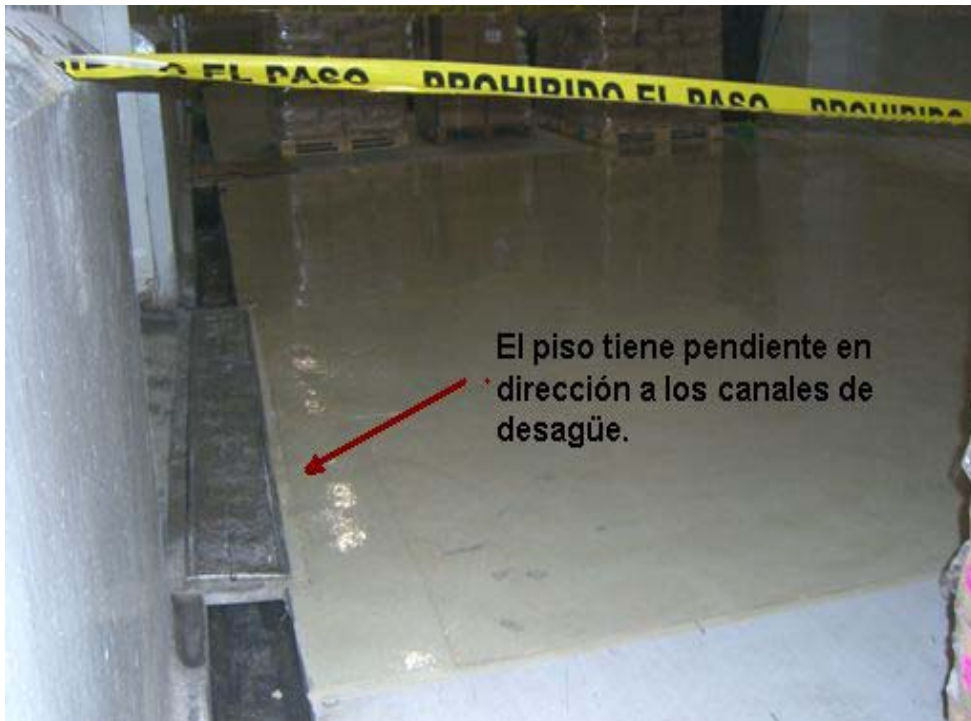
Foto 21. Adecuación de piso con acabado epóxico, con pendiente dirigida hacia canales de desagüe, para facilitar las tareas de limpieza
