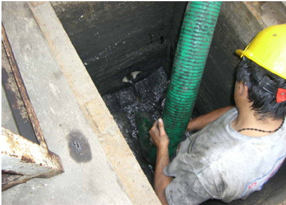
Foto17. Desazolve por medio de equipo mecánico de succión
