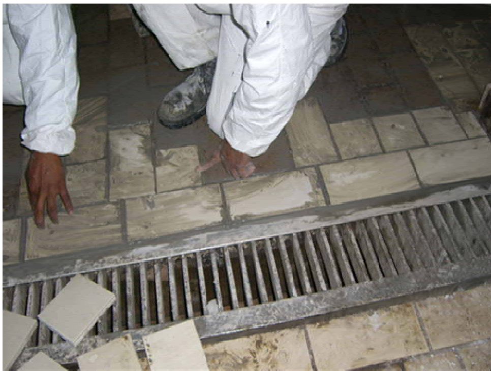
Foto 3. Mantenimiento Correctivo de pisos de loseta antiácida en áreas de producción
