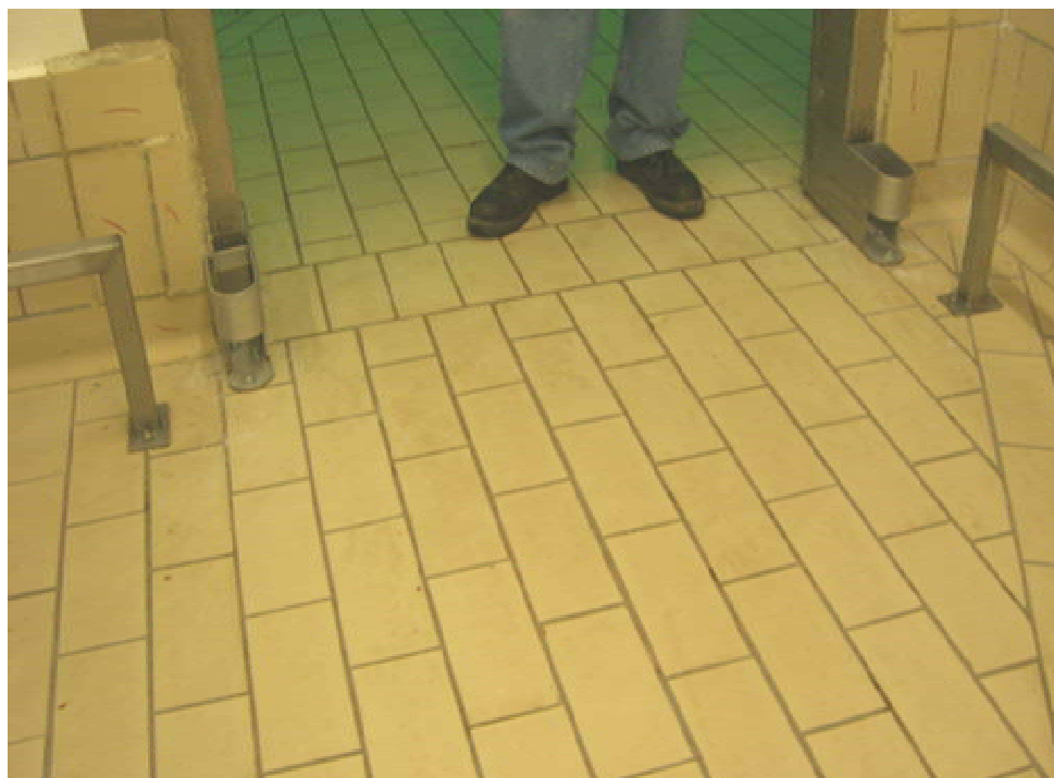
Foto 4. Piso recubierto con loseta antiácida totalmente terminado
