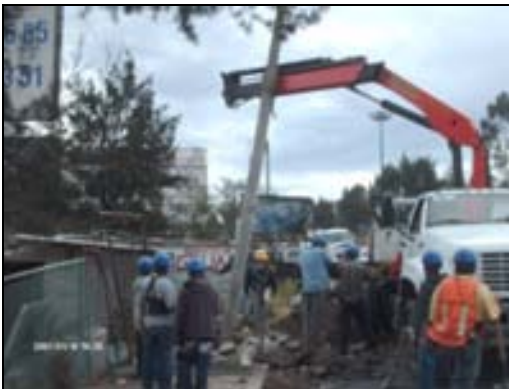
Figura IV.12 Proceso de Izaje.
