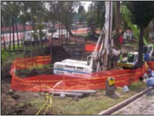
Figura IV.17 Hincado de Pilotes.
