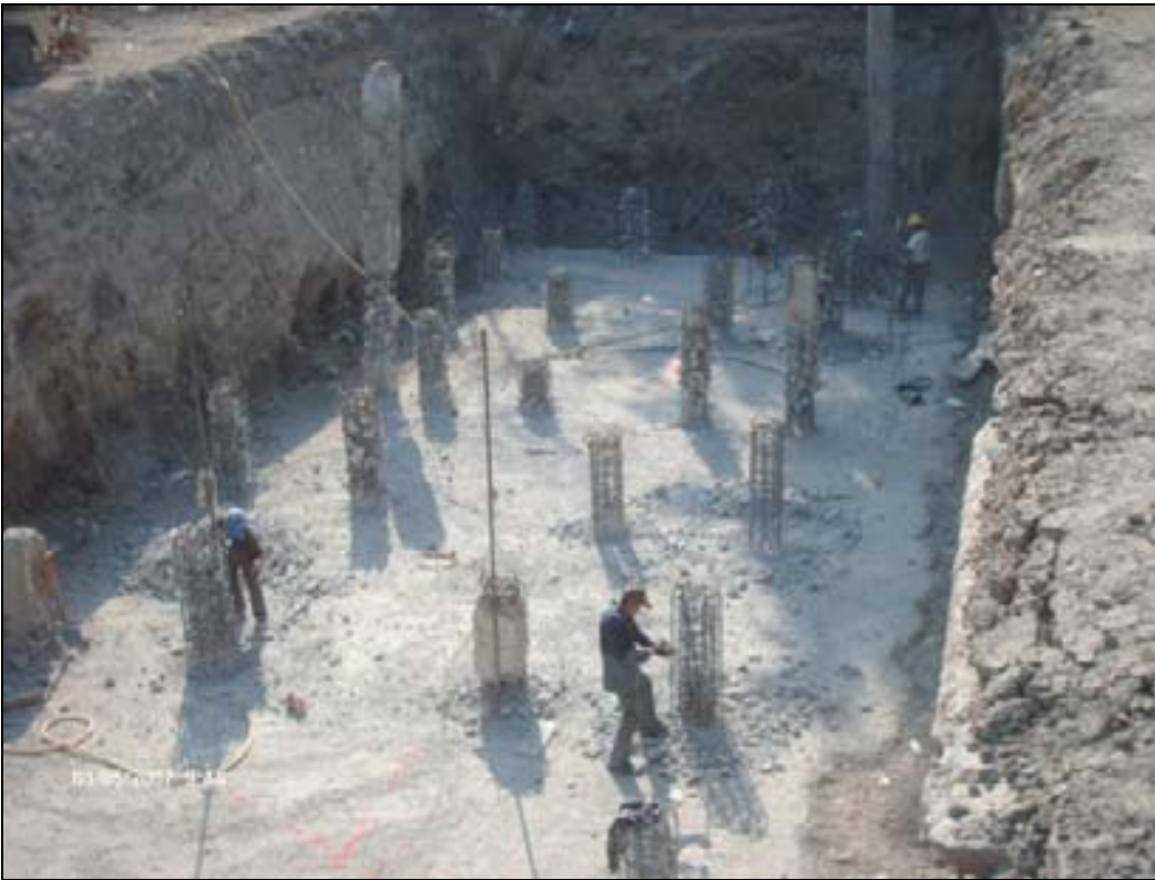
Figura V.16 Descabece de Cimentación Profunda.
