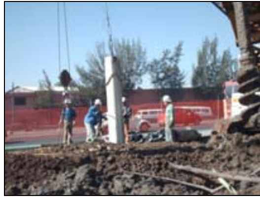
Figura IV.18 Verificación de verticalidad.
