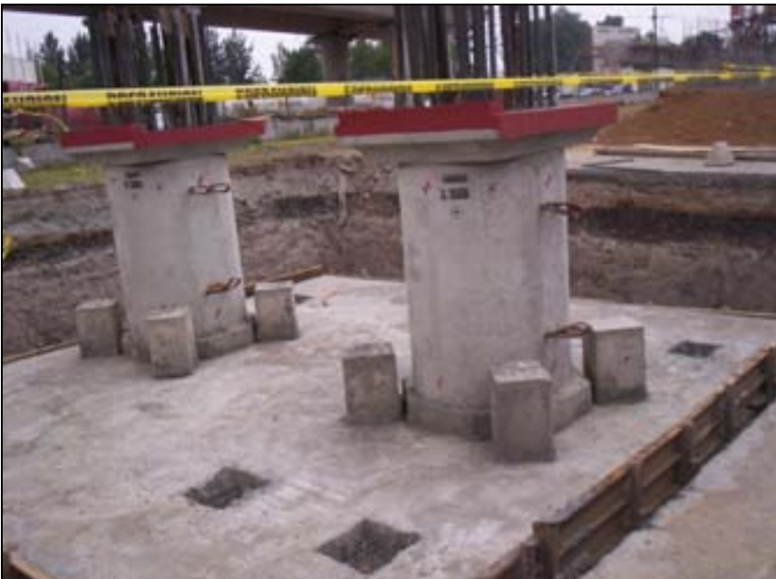
Figura V.28 Unión Final de Cimentación con Superestructura
