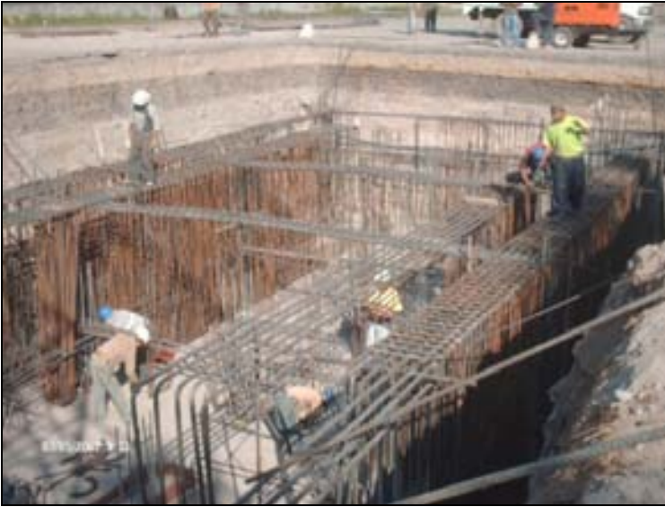
Figura V.21 Armado de contratraves.
