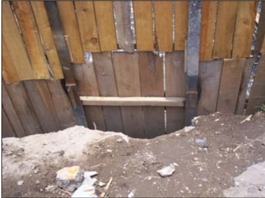
Figura V.9 Muro de contención.
