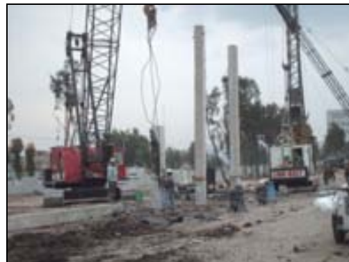
Figura IV.13 Verificación de verticalidad.
