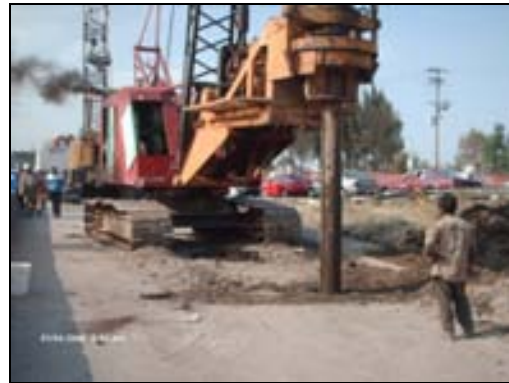
Figura IV.11 Proceso de Barrenación.
