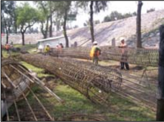
Figura III.8 Acero de Refuerzo de Pilas.
