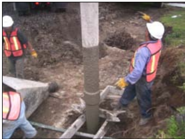
Figura III.16 Colado de la Pila.
