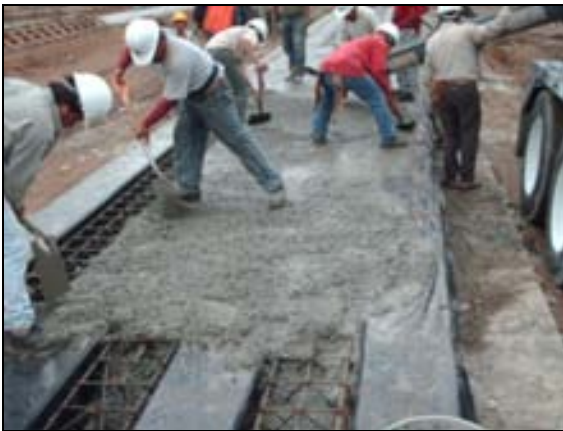
Figura IV.3 Colado de Pilotes.
