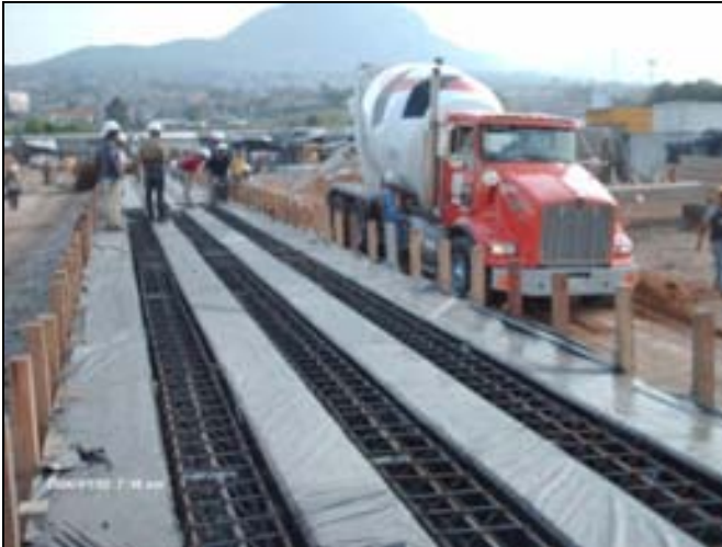
Figura IV.2 Fabricación de Pilotes.
