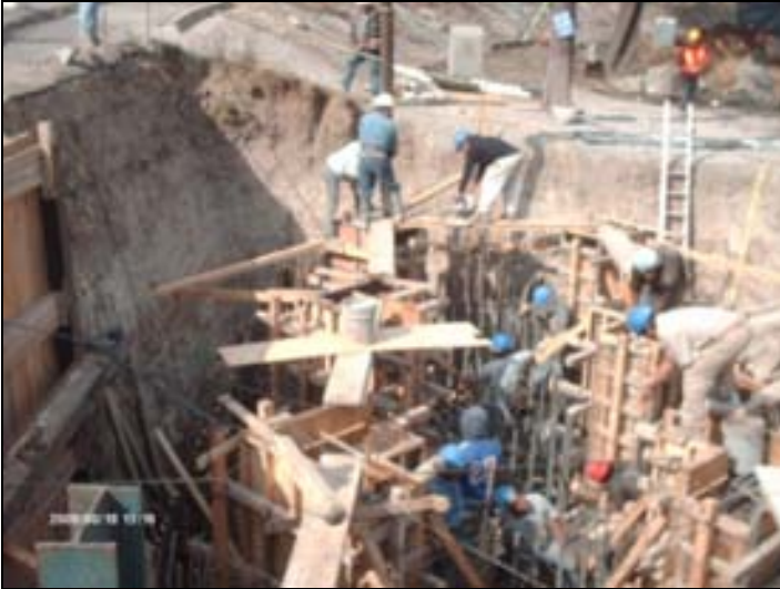
Figura V.19 Cimbrado de contrafuertes.
