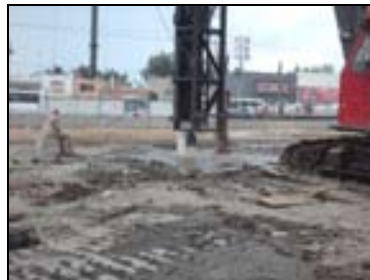
Figura IV.20 Rechazo del Estrato Firme
