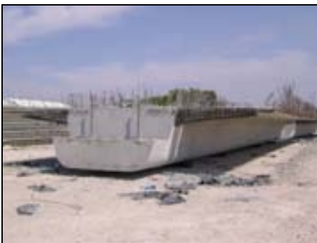
Figura I.11 Trabes cajón.
