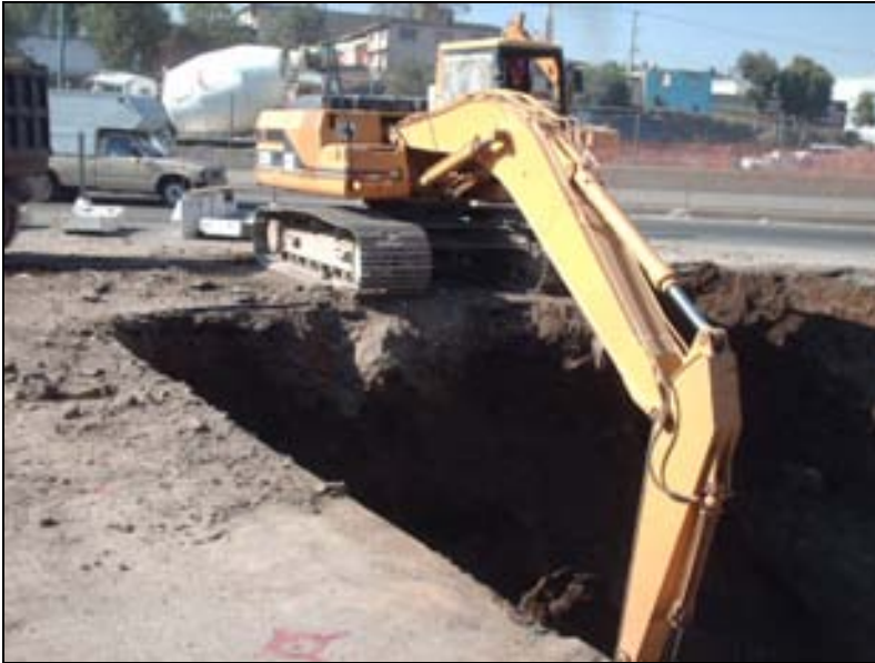
Figura V.17 Proceso de Excavación
