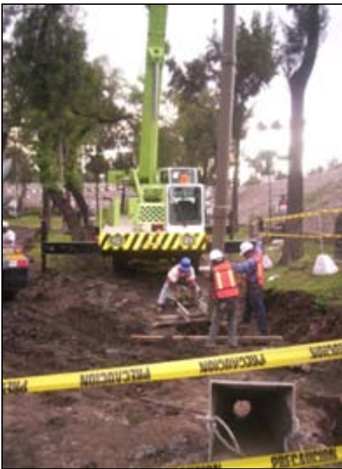
Figura III.15 Colocación del Tubo Tremie.
