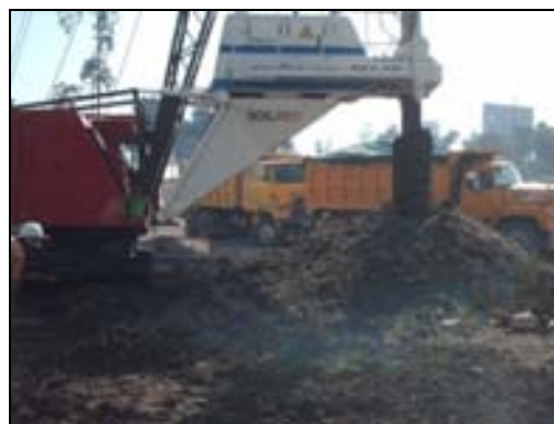
Figura III.5 Proceso de Perforación.
