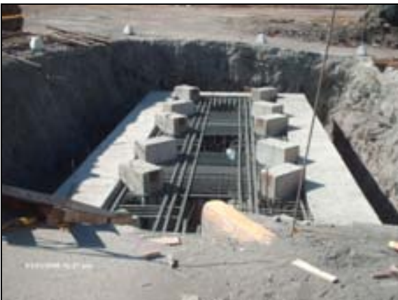
Figura I.8 Zapatas de cimentación.
