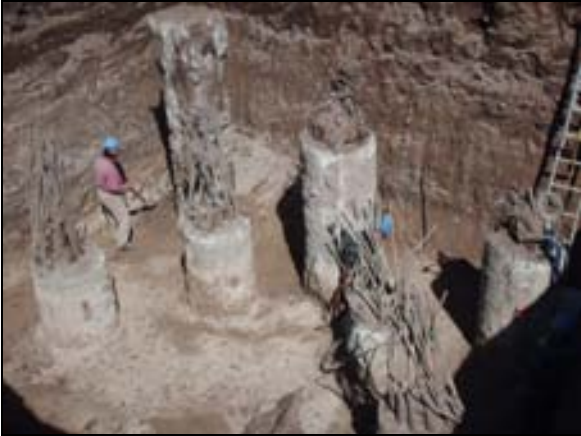
Figura I.6 Pilas coladas en sitio.
