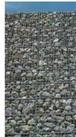
Fig. 89. Muro de piedras enclaustradas por estructura metálica.
