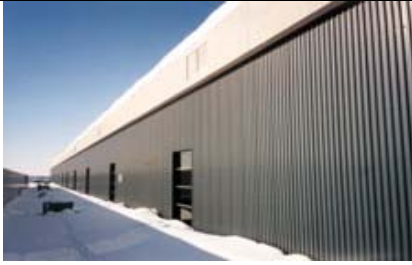
Sistema Matrixair aplicado a muro de fábrica canadiense
