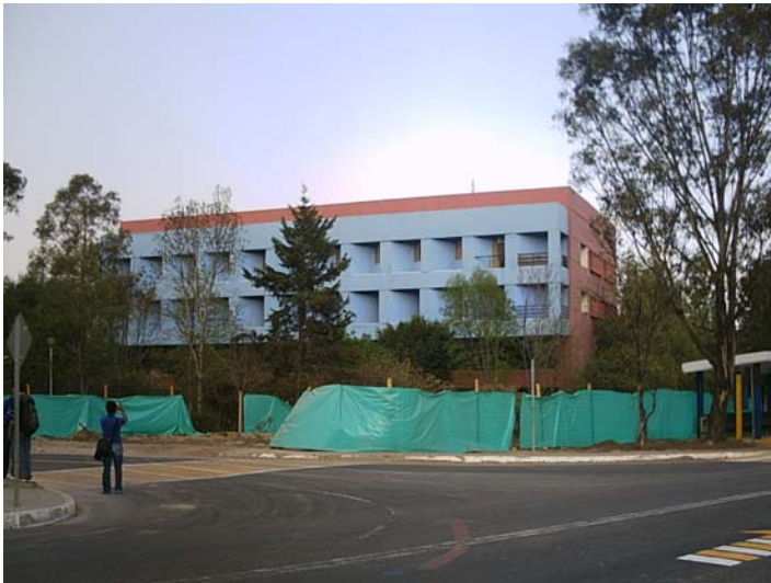
Ilustración: Vista desde el par vial al edificio de Universum
