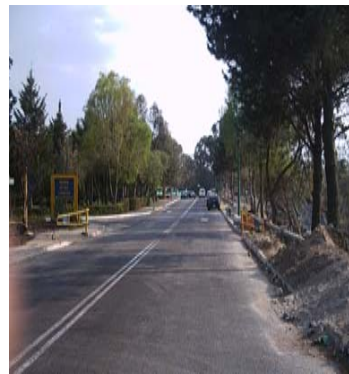
Vista vialidad actual
