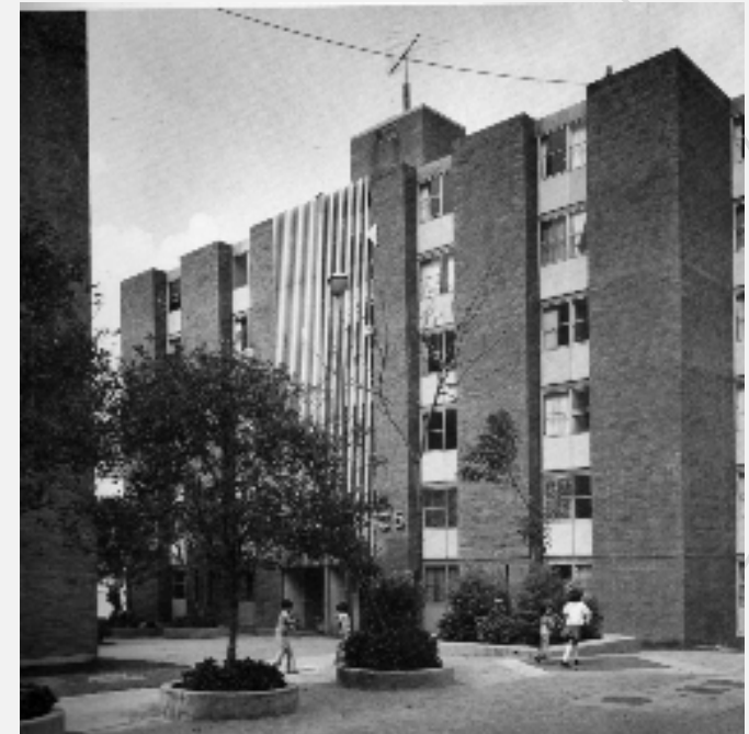
Torres de Mixcoac. Edificio de departamentos de 5 niveles
