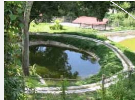
Captación de agua por medio estanques
