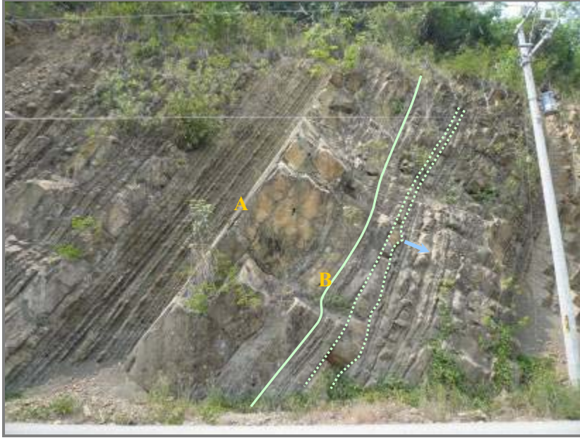
Fig. 4.1.33. Megarizaduras (A: base, B: cima). Estructura en forma cuspada por escape de fluidos (línea punteada); la flecha indica el sentido de flujo.
