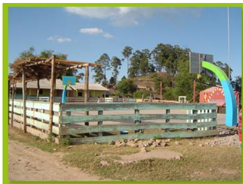
Figura 6. Escuela rural Primaria con cancha
