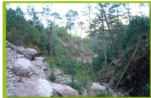
Figura 3. (Derrumbes y/o talud carcavamiento)
