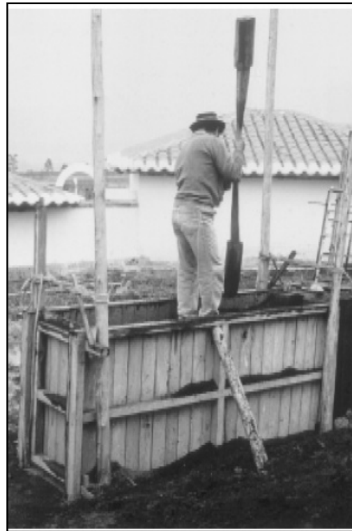
FIGURA 16: PISON DE DOS CABEZAS EMPLEADO EN EL APISONAMIENTO DE TAPIAL.
