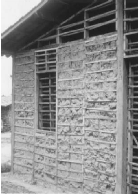
FIGURA 17: PARED DE BAHAREQUE FUENTE: Muros de Bahareque. De: http://desastres.usac.edu.gt/documentos/pdf/spa/doc14388/doc14388-c.pdf .
