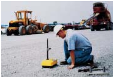
Fig. 6-13. Los medidores nucleares que contienen fuentes radioactivas se usan para medir la densidad del suelo y la humedad pueden determinar si se compactó adecuadamente la subbase
