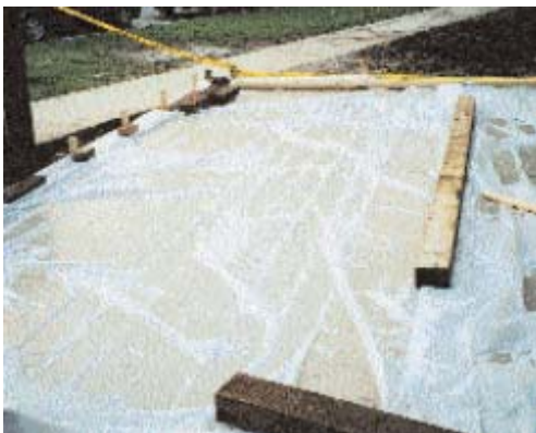
Fig. 6-30. La película de polietileno es una barrera de humedad efectiva para el curado del concreto y se la puede aplicar fácilmente tanto en formas complejas como en sencillas. Para minimizar la decoloración, la película se debe mantener lo más llano posible sobre la superficie de concreto.
