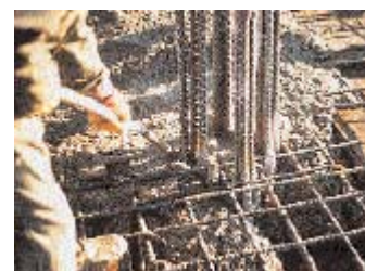
Fig. 6-7. Agujero y concentración de piedras son el resultado de la consolidación inadecuada.
