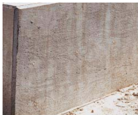
Fig. 1-6. Una buena consolidación es necesaria para lograrse un concreto denso y durable. Una consolidación pobre puede resultar en corrosión temprana de la armadura (refuerzo) y baja resistencia compresión.
