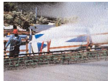
Fig. 6-27. La niebla minimiza la pérdida de humedad durante y después de la colocación y el acabado del concreto
