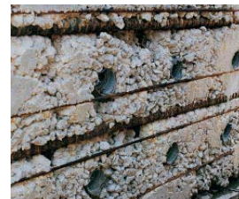
Fig. 1-6. Una buena consolidación es necesaria para lograrse un concreto denso y durable. Una consolidación pobre puede resultar en corrosión temprana de la armadura (refuerzo) y baja resistencia compresión.
