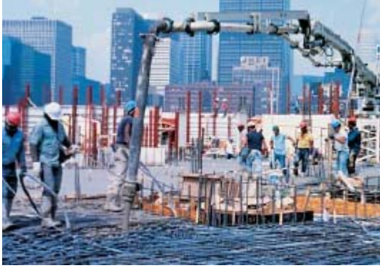
Fig. 5-17. Un aguilón montado sobre un mástil y localizado cerca del centro de la estructura puede frecuentemente llegar a todos los puntos de la colocación. Se usa principalmente en edificios altos donde las torres de grúa no se pueden ocupar de la colocación del concreto. Éste se alimenta al aguilón a través de la tubería proveniente de la bomba ubicada en el nivel del terreno. Con estos métodos, el concreto se puede bombear verticalmente por cientos de metros (pies).
