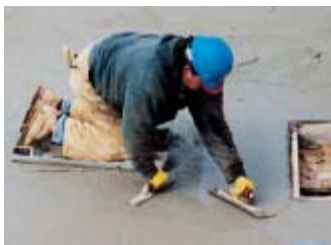
Fig. 6-17. Emparejado manual (mano derecha) de la superficie con una aplanadora (flota, talocha, aplanadera) mantenida de manera plana sobre la superficie del concreto y movida en arco con un movimiento ligeramente cortante. El alisado (mano izquierda) con la hoja inclinada se realiza antes de mover el tablón para las rodillas
