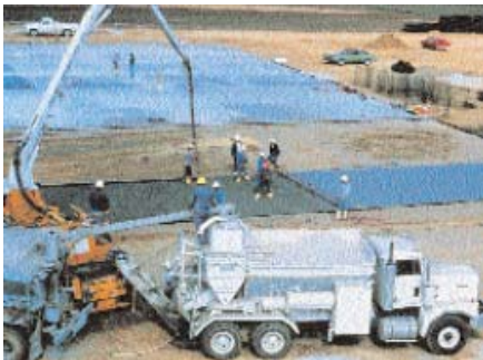
Fig. 5-6. La dosificadora móvil mide los materiales por volumen y mezcla continuamente, a medida que los ingredientes secos, agua y aditivos se alimentan dentro del tambor de mezclado en la parte trasera del vehículo.
