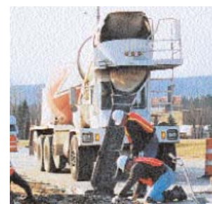
Fig. 5-9. El concreto premezclado normalmente se lo puede colocar en su localización final a través de la descarga directa por el canalón desde el camión mezclador.
