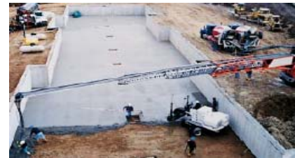
Fig. 5-12. La estera (banda) transportadora es un método eficiente y portátil para el manejo del concreto. Un canalón previene que el concreto segregue al dejar la estera. El tractor raspador previene la pérdida de mortero. Las esteras transportadoras se pueden operar en series y sobre los aguilones extensibles (plumas telescópicas) de las grúas hidráulicas.
