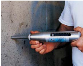
Fig. 7-19. El esclerómetro da una buena indicación de la resistencia a compresión del concreto.
