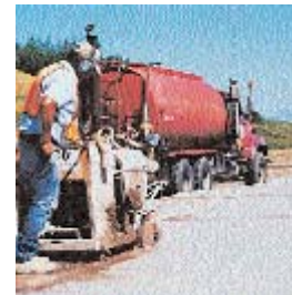
Fig. 6-21. Juntas de contracción proveen el movimiento horizontal en el plano de la losa o del muro e induce fisuras controladas que se causan por la contracción por secado y térmica.
