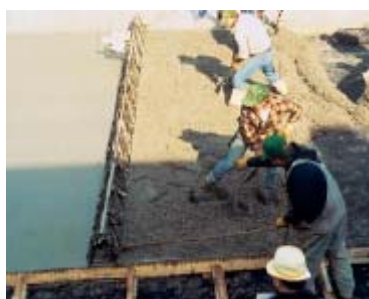
Fig. 6-10. Las reglas (plantillas) vibratorias, tales como la unidad de armadura, reducen el trabajo de
