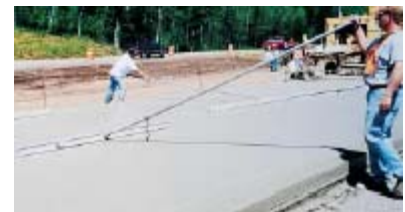
Fig. 6-14. (superior) El aplanado lleva la superficie al nivel especificado y se hace en áreas estrechas donde las talochas no pueden alcanzar. El aplanado se debe completar antes que el agua de sangrado (exudación) se acumule sobre la superficie.
