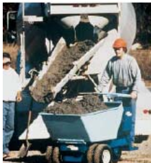
Fig. 5-7. La versátil carretilla motorizada puede mover todo tipo de concreto en distancias pequeñas.
