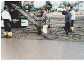
Fig. 3-16. El concreto fluido con alto revenimiento (superior) se coloca fácilmente (medio), incluso en áreas con alta congestión de armadura (inferior).
