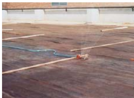
Fig. 6-28. Los aspersores de césped saturan el yute con
