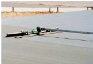
Fig. 6-18. El cepillado provee una superficie resistente al resbalón, principalmente usado en concretos exteriores.
