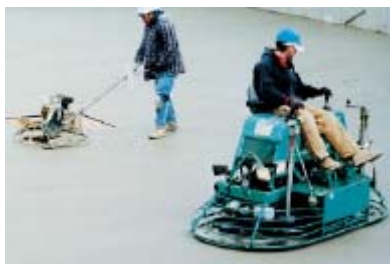
Fig. 6-16. El emparejado mecánico usando un equipo portátil "walk-behind" y un equipo de montar. Las pisadas indican el momento adecuado. Cuando el brillo del agua de sangrado se haya evaporado y el concreto pueda sostener la presión de los pies con sólo un pequeño hundimiento, la superficie está lista para el emparejado y las operaciones de acabado.
