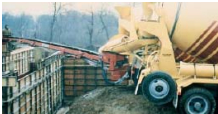
Fig. 5-13. La estera transportadora montada sobre el camión mezclador coloca el concreto hasta 12 metros (40 pies) sin la necesidad de ningún equipo adicional de manejo.
