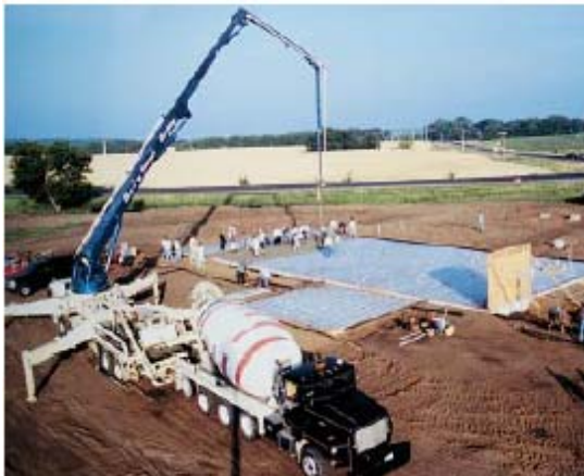
Fig. 5-14 (Izquierda) Una bomba montada sobre el camión y un aguilón pueden convenientemente mover el concreto verticalmente y horizontalmente para la posición deseada. (Derecha) Vista de la descarga del concreto de una manguera flexible conectada a la tubería rígida que se dirige de la bomba. La pipa (tubo) se usa en los aguilones de bombeo para mover el concreto hasta distancias relativamente largas. Hasta 8 m (25 pies) de manguera flexible se puede conectar a la extremidad de la tubería rígida para mejorar la movilidad de colocación.
