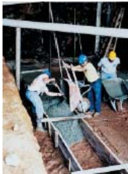
Fig. 6-4. Las carretillas se usan para colar (colocar) el concreto en áreas que no tienen acceso por otros métodos.
