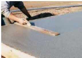
Fig. 6-14. (superior) El aplanado lleva la superficie al nivel especificado y se hace en áreas estrechas donde las talochas no pueden alcanzar. El aplanado se debe completar antes que el agua de sangrado (exudación) se acumule sobre la superficie.
