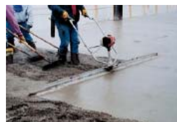
Fig. 6-10. Las reglas (plantillas) vibratorias, tales como la unidad de armadura, reducen el trabajo de
