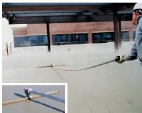
Fig. 6-14. (inferior) Las llanas de mango largo de carreteras se usan en los pavimentos de las carreteras y en la construcción de pisos donde se desean superficies muy planas.
