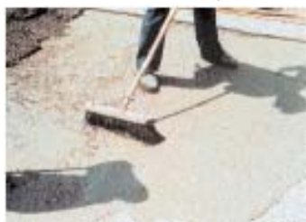
Fig. 6-20. Aplicación de groute de adherencia delante de la capa superior de concreto. El groute no puede secarse antes que se coloque el concreto
