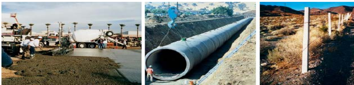
Fig. 2-13. Los cementos de moderada resistencia a los sulfatos y alta resistencia a los sulfatos mejoran la resistencia a los sulfatos de los miembros de concreto, tales como (de la izquierda a la derecha) losas sobre el suelo, tubería y postes de concreto expuestos a suelos con alto contenido de sulfatos
