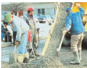
Fig. 5-9. El concreto premezclado normalmente se lo puede colocar en su localización final a través de la descarga directa por el canalón desde el camión mezclador.
