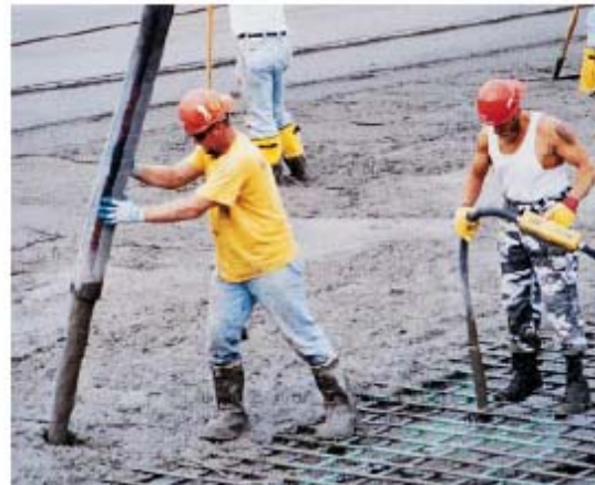
Fig. 5-14 (Izquierda) Una bomba montada sobre el camión y un aguilón pueden convenientemente mover el concreto verticalmente y horizontalmente para la posición deseada. (Derecha) Vista de la descarga del concreto de una manguera flexible conectada a la tubería rígida que se dirige de la bomba. La pipa (tubo) se usa en los aguilones de bombeo para mover el concreto hasta distancias relativamente largas. Hasta 8 m (25 pies) de manguera flexible se puede conectar a la extremidad de la tubería rígida para mejorar la movilidad de colocación.
