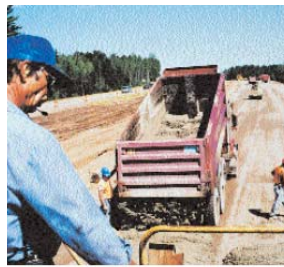
Fig. 5-3. Mezclado en central en una mezcladora estacionaria con tambor basculante y entrega con camión mezclador operando en velocidad de agitación.
