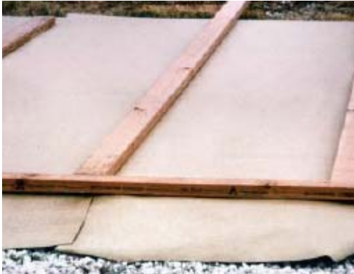
Fig. 6-29. Papel impermeable para curado es una medida eficiente de curado horizontal de superficies.
