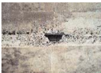
Fig. 6-7. Agujero y concentración de piedras son el resultado de la consolidación inadecuada.
