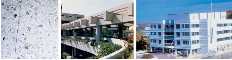
Fig. 2-16. El cemento portland blanco se utiliza en concreto arquitectónico blanco o de colores claras, variando de (de la izquierda para la derecha) terrazos para pisos, enseñado aquí con cemento blanco y agregado de granito verde (IMG12475), para miembros decorativos estructurales premoldeados o moldeados en obra (68981), para el exterior de los edificios. La foto de la derecha muestra el edificio en concreto premoldeado blanco de la sede de la ASTM en West Conshohocken, Pennsylvania. La foto es cortesía de la ASTM.
