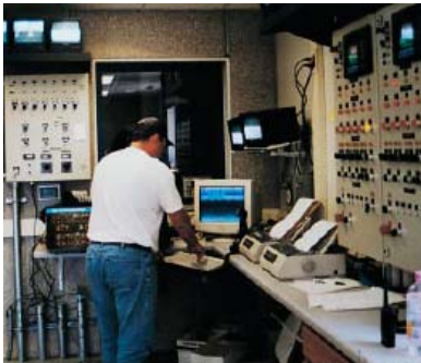
típica de concreto premezclado.
