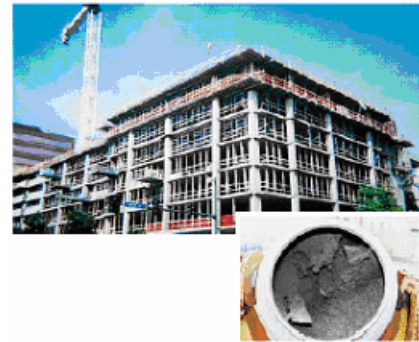
Fig. 4-1. (inferior) La mezcla de prueba verifica si el concreto cumple con los requisitos de diseño antes de su empleo en la obra.
