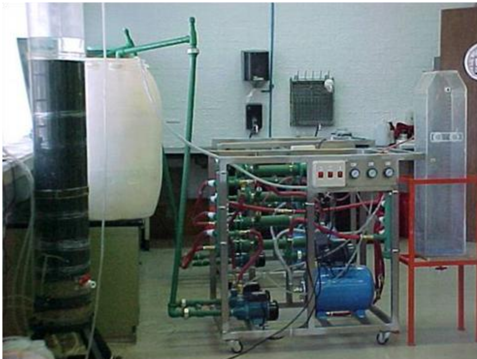
Figura 3.4. Sistema de ultrafiltración y filtro de arena
