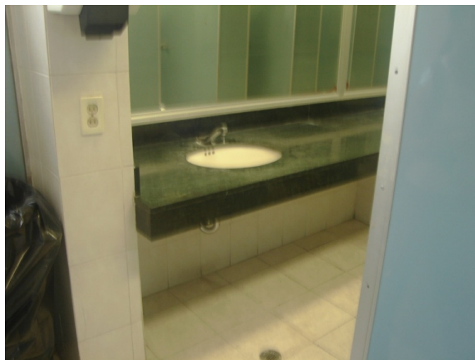
Figura IV.68. Lavamanos ala poniente.
