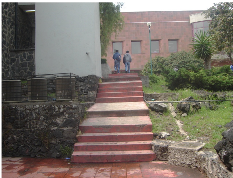
Figura IV.20. Escaleras que colindan con el Auditorio Sotero Prieto
