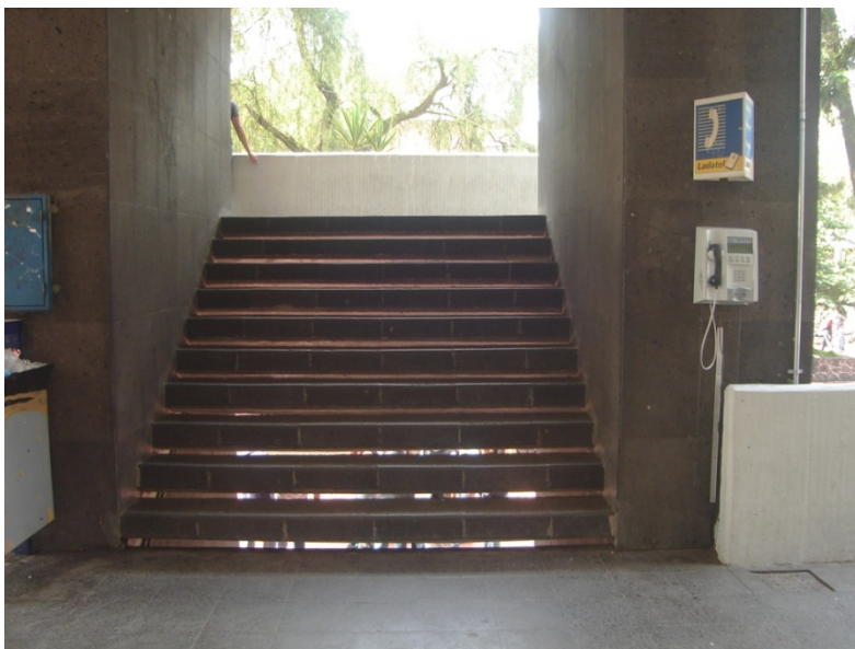
Figura IV.19. Escaleras Edificio Norte.
