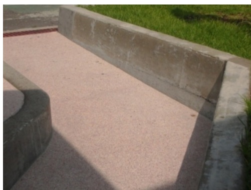
Figura IV.12. Rampa del Centro de Docencia
