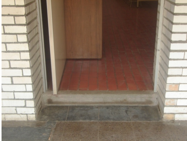
Figura IV.40. Escalón en laboratorios de ciencias básicas.
