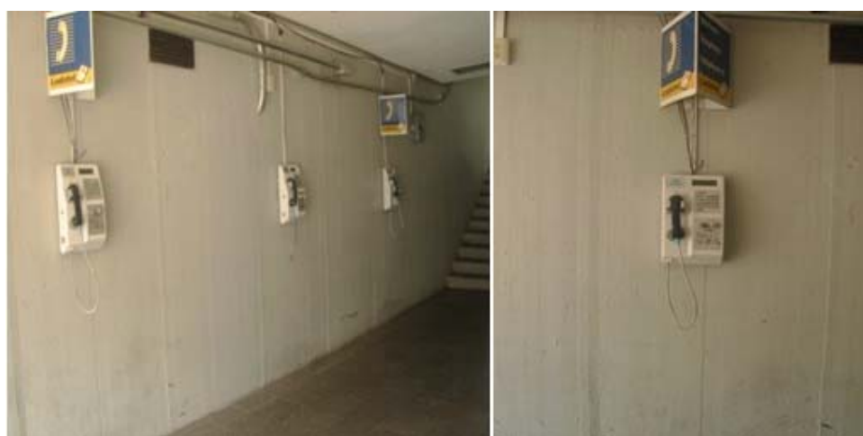
Figura IV.26. Teléfonos públicos. Ala poniente de las instalaciones
