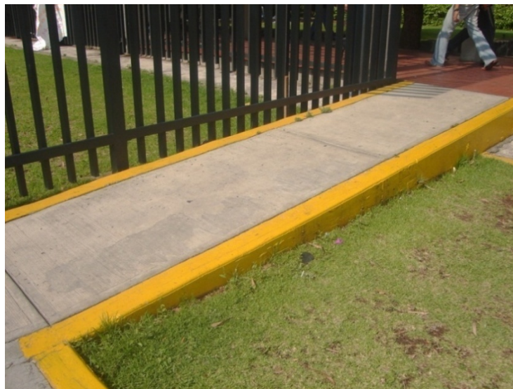
Figura IV.11. Rampa 2 del Estacionamiento para alumnos del Anexo de Ingeniería
