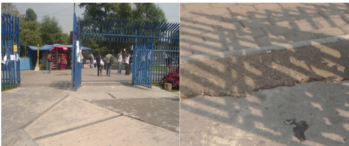
Figura IV.28. Entrada principal al Anexo por “Camino verde” (Ala Norte).
