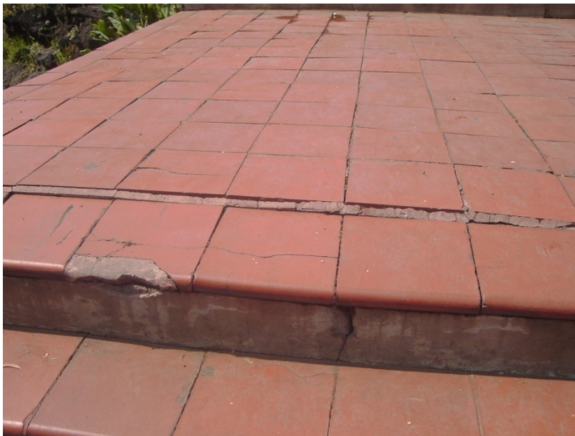
Figura IV.22. Detalle del escalón, escaleras principales Anexo de Ingeniería.
