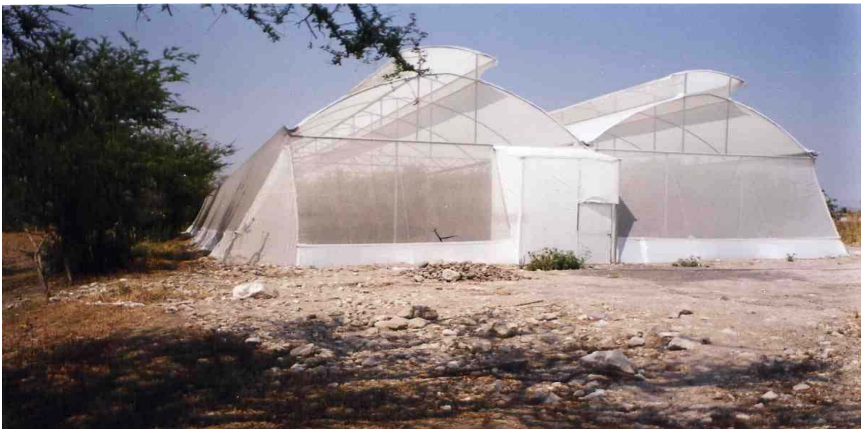
Foto. 1. INVERNADEROS TIPO TUNEL DE DOBLE VENTILA CENTAL.
