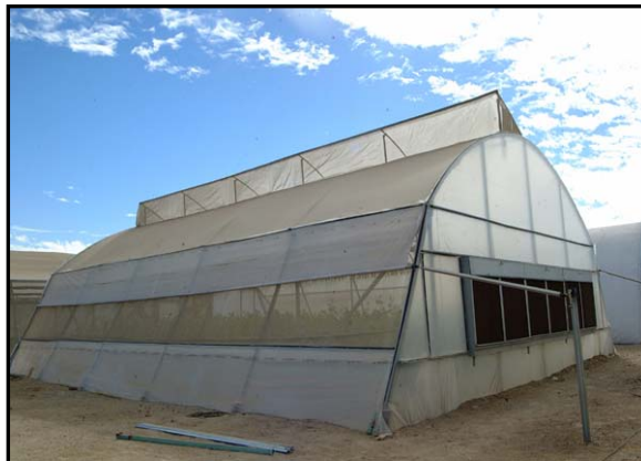
Fig. 10. INVERNADERO TIPO CAPILLA.
