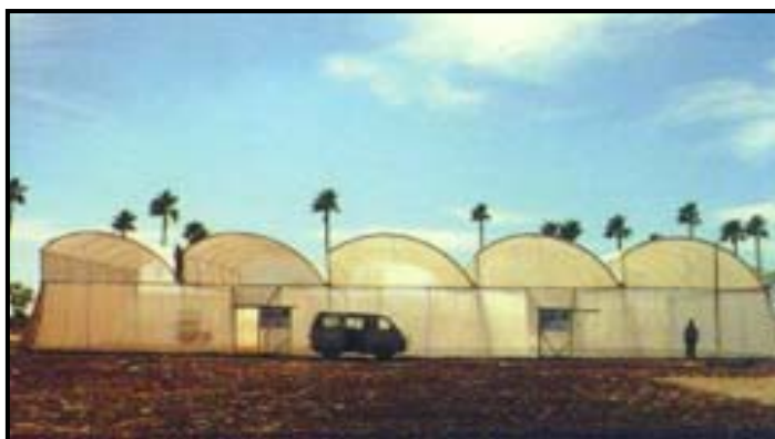
Fig. 12. INVERNADERO TIPO DIENTE DE SIERRA.
