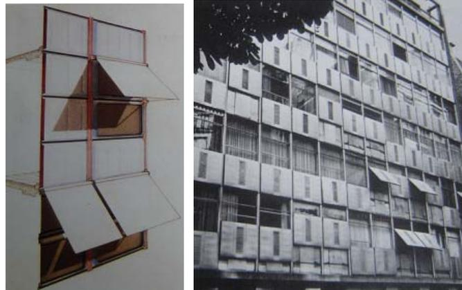
Izquierda: Diseño de panel para fachada concurso para escuela de prefabricados, derecha: Edificio de la Plaza Mozart, Paris 1953.- Fachada polivalente y variable en función de distintas necesidades como visión, ventilación o protección solar.
