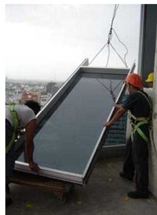
Foto: montaje de fachada en Edificio HSBC
