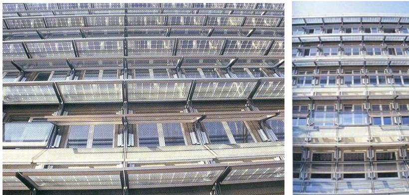
Paneles fotovoltaicos integrados al sistema de fachada
