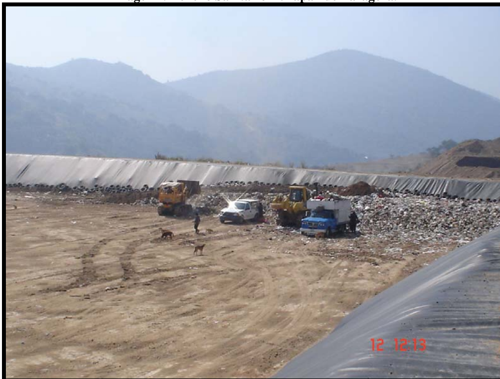
Imagen 1. Relleno Sanitario Atizapán de Zaragoza.
