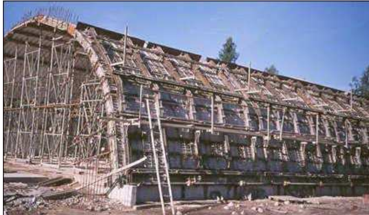
FIGURA 16. Imagen del proceso constructivo de un hangar y su estado final.
