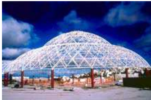
FIGURA 34. Estructura espacial semi esférica.
