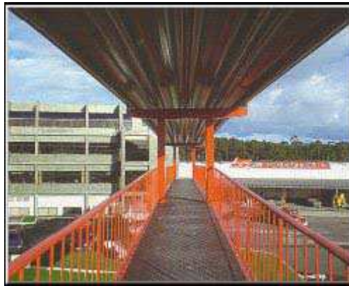
FIGURA 3. Una cubierta recta de una pasarela.
