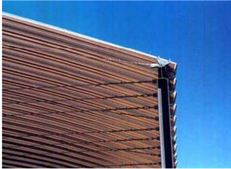
FIGURA 9. Tirantes interiores para una cubierta curva.
