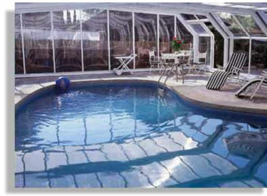
FIGURA 63. Cubierta telescópica de una alberca.
