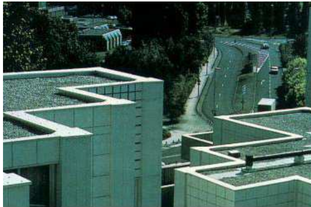
FIGURA 59. Sistema de impermeabilización.
