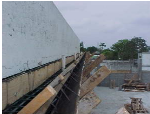
FIGURA 76. Colado del canalón.
