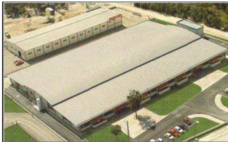
FIGURA 5. Ejemplo de una cubierta plana de una nave industrial.
