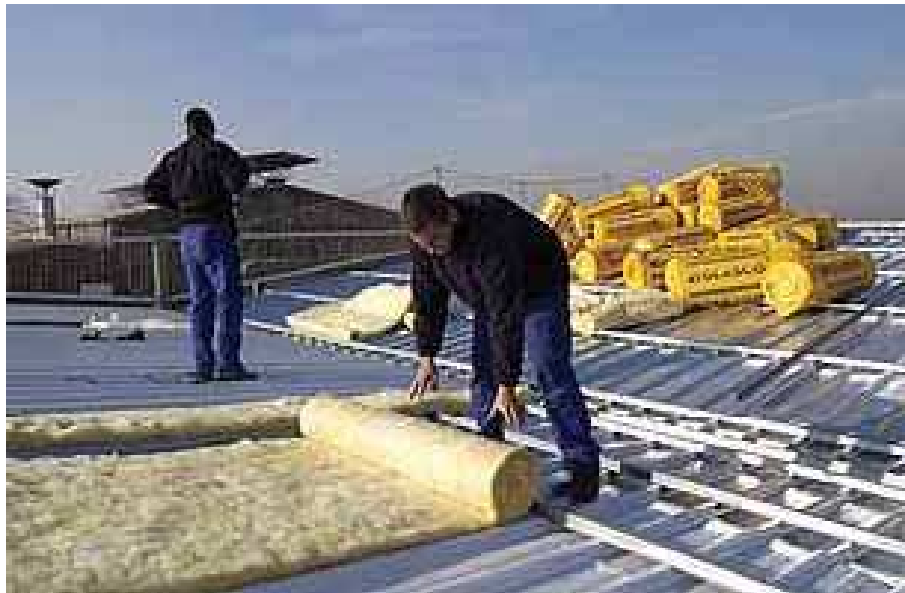
FIGURA 28. Desenrollo de la fibra de vidrio.
