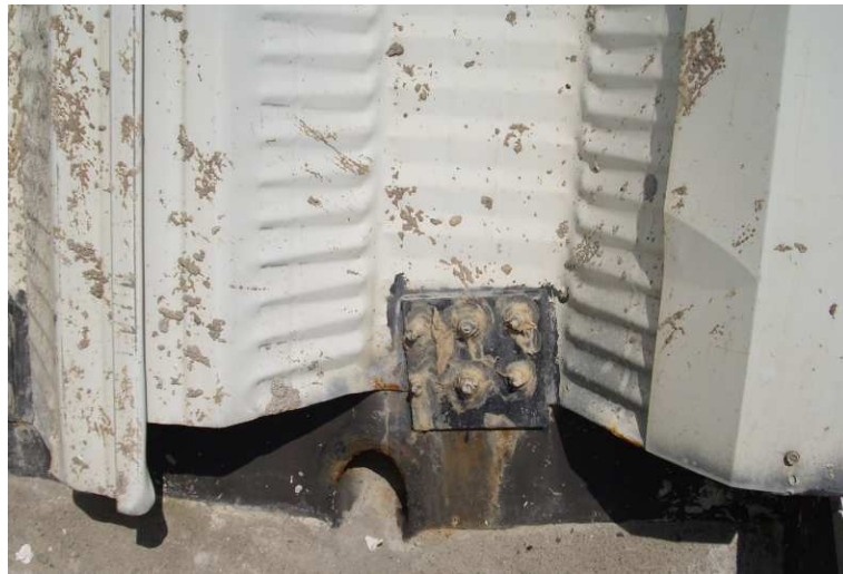
FIGURA 74. Placa de fijación.
