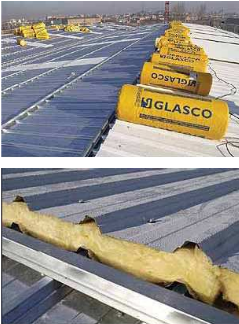
FIGURA 29. Detalle de la manta de fibra de vidrio en un panel sándwich.
