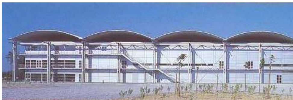
FIGURA 17. Imagen de cubiertas autoportantes curvas.
