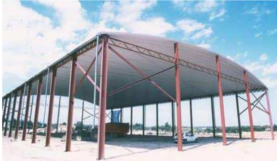
FIGURA 22. Imagen muestra arriostramiento transversal de una nave industrial.
