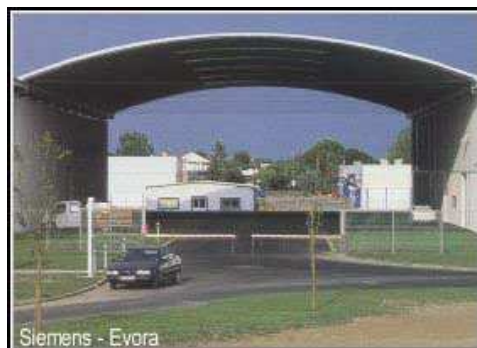
FIGURA 7. Imagen de una cubierta curva de un estacionamiento.
