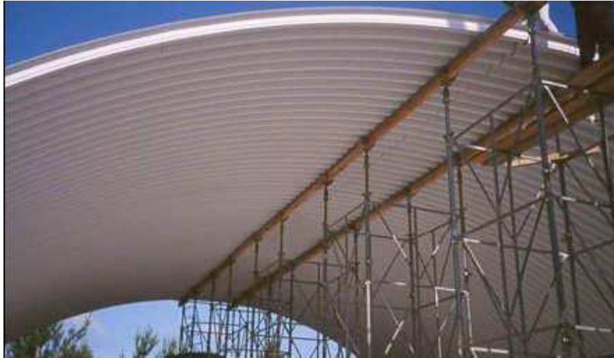
FIGURA 12. Una cubierta autoportante curva.
