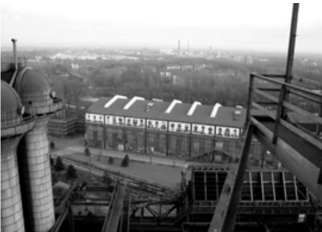
Fábricas viejas de acero en la cuenca del Ruhr, próximo al río Emscher en Alemania, lugar conocido como "la ciudad prohibida" y ahora convertido en el IBA Emscher Park. (Moseler, circa 2002).
